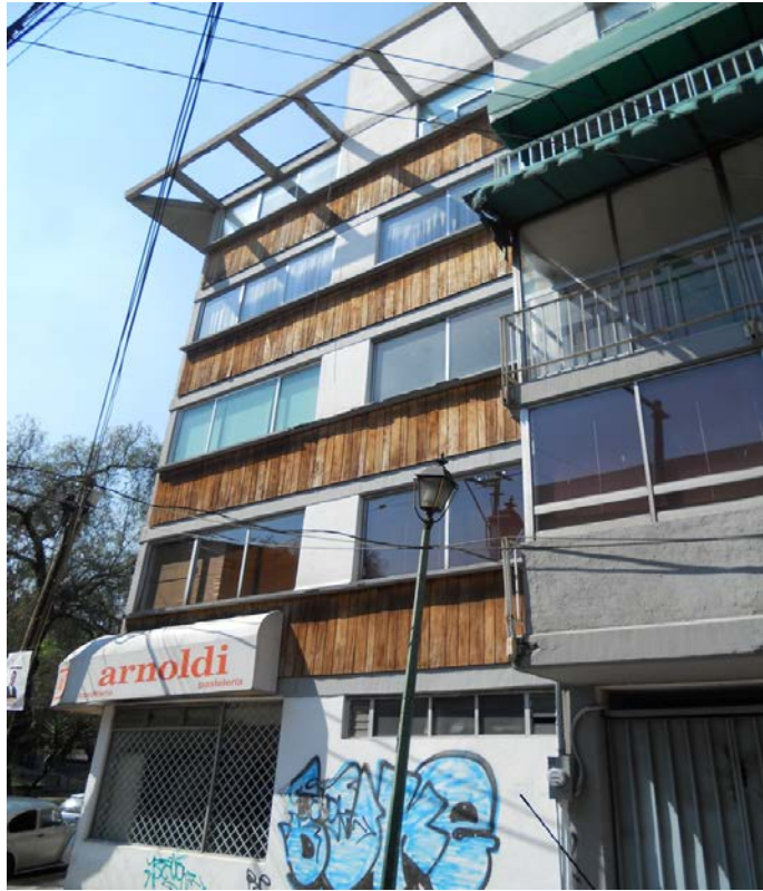
Edificio de departamentos, esquina Angelina y Camino al Desierto de los Leones. Planta baja con comercio y 4 niveles. Fotografía tomada por el autor
