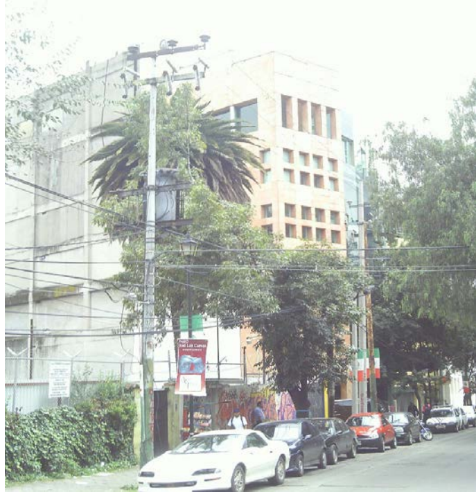
Edificio de oficinas al oriente del predio. Planta baja y 5 niveles. Fotografía tomada por el autor
