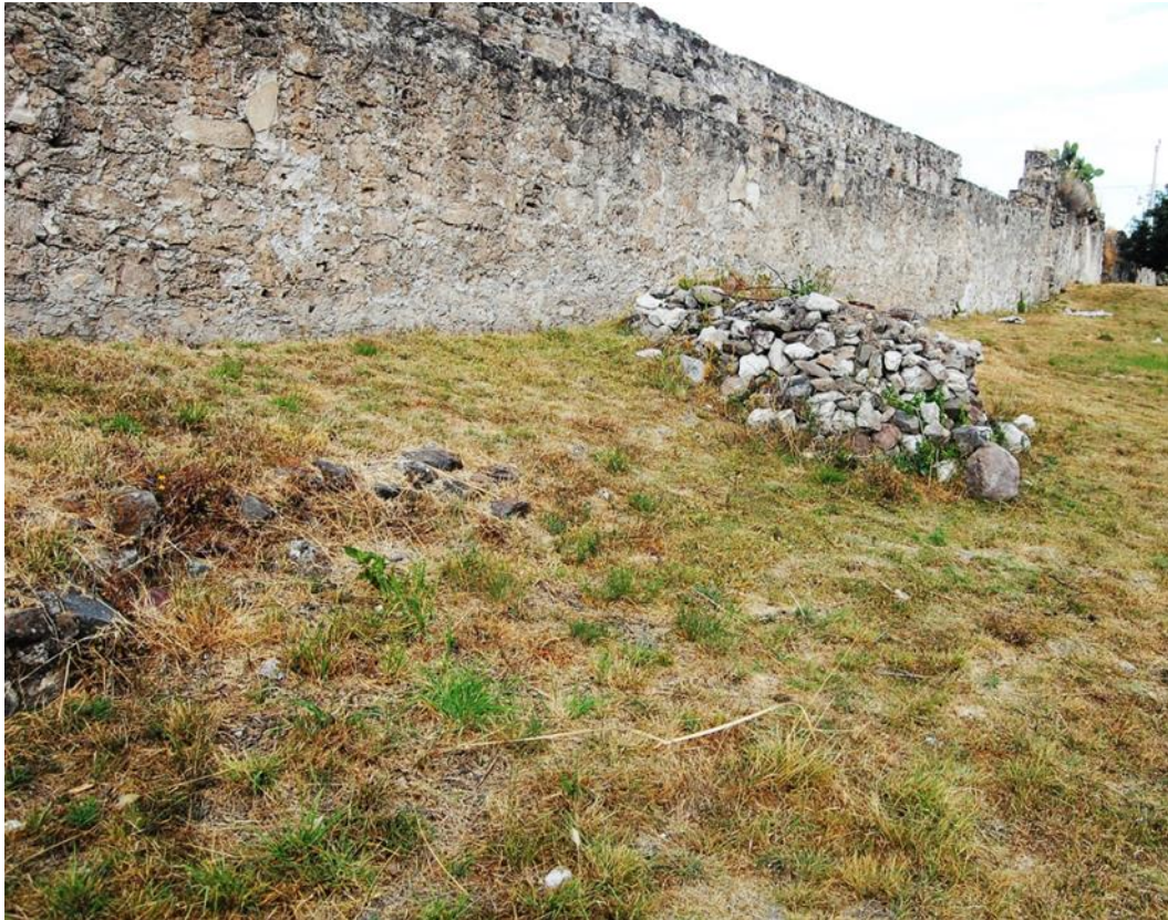
Fig. 18. Elevación contigua a la barda del atrio, posibles restos de un ambón. Segmento C (fig. 16). Del autor (2012).
