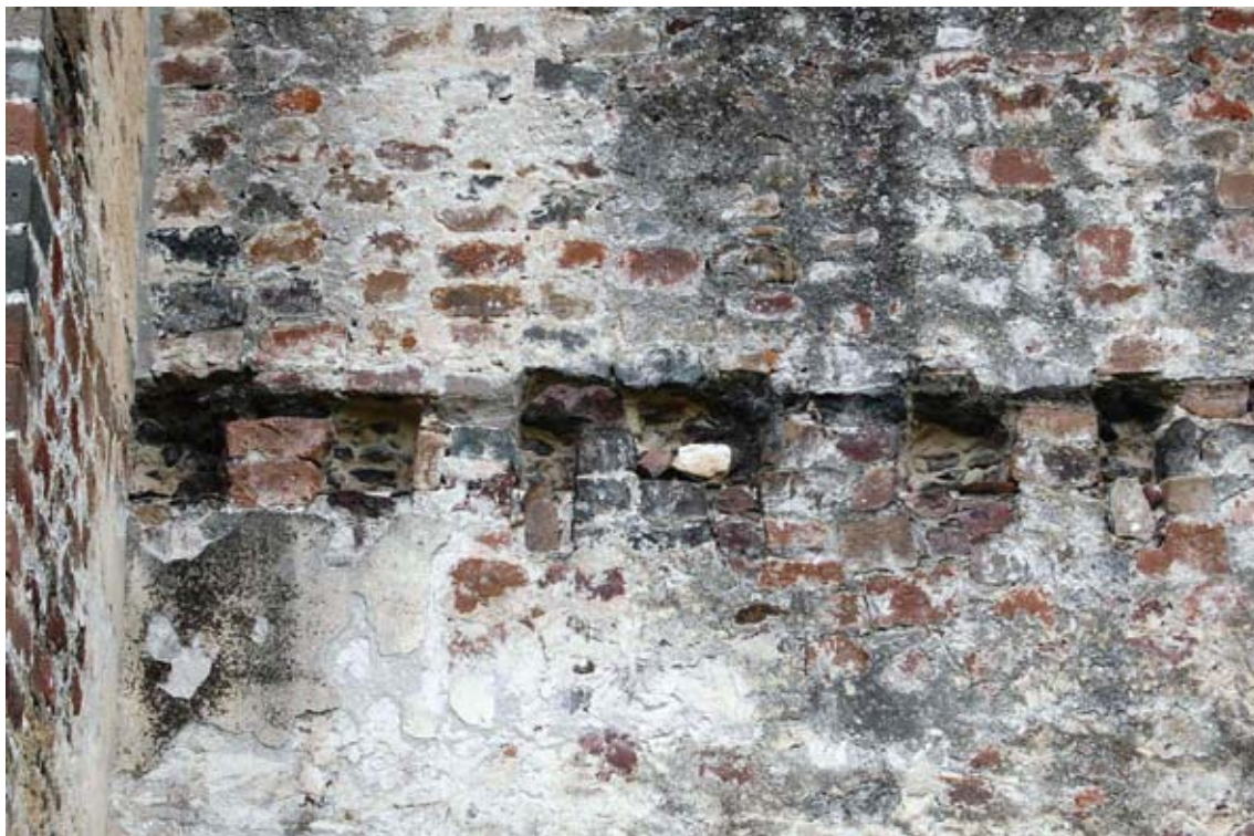
Fig. 26. Entradas de vigas segmento G. Del autor (2011).
