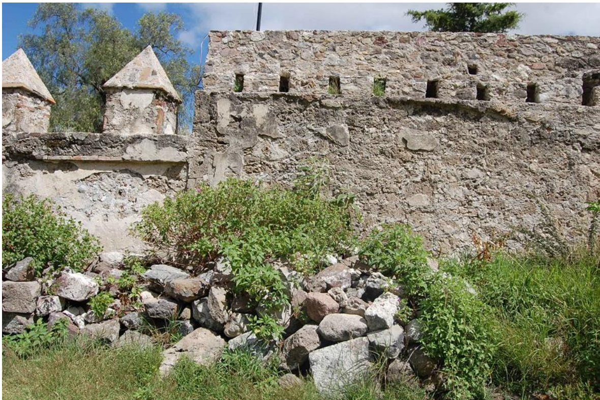
Fig. 17.1. Mechinales en la barda del atrio. Del autor (2011).
