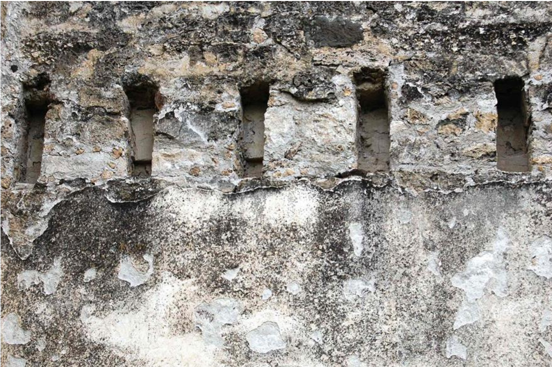
Fig. 25. Entradas de vigas segmento F. Del autor (2011).
