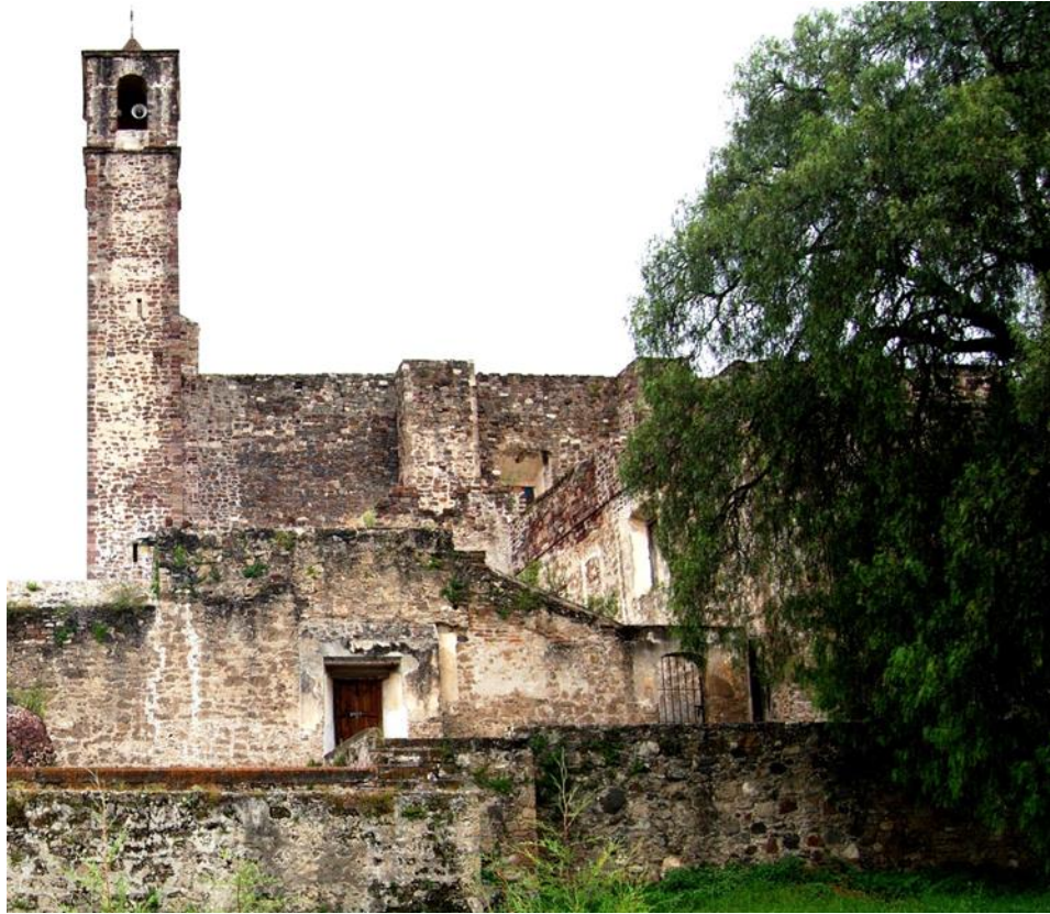
Fig. 33. Muro sur de la iglesia, parte superior. Del autor (2011).
