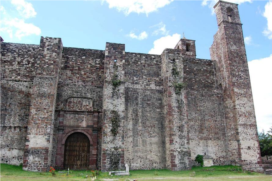
Fig. 32. Muro norte de la iglesia, cara exterior. Del autor (2011).
