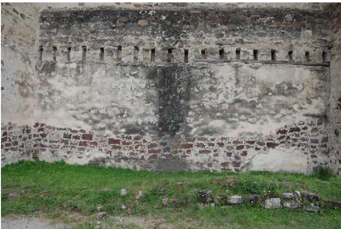
Fig. 22. Muro norte de la iglesia con 18 mechinales. Segmento F (fig. 16). Del autor (2011).
