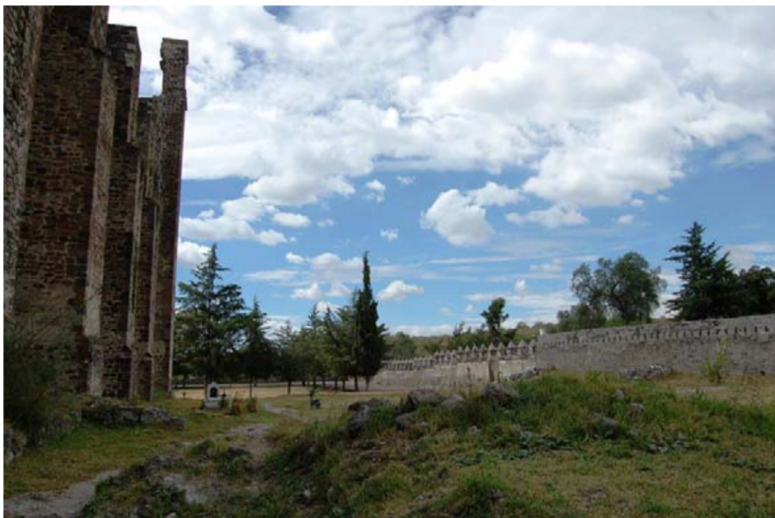
Fig. 14. Zona norte con vestigios de construcción. Del autor (2011).
