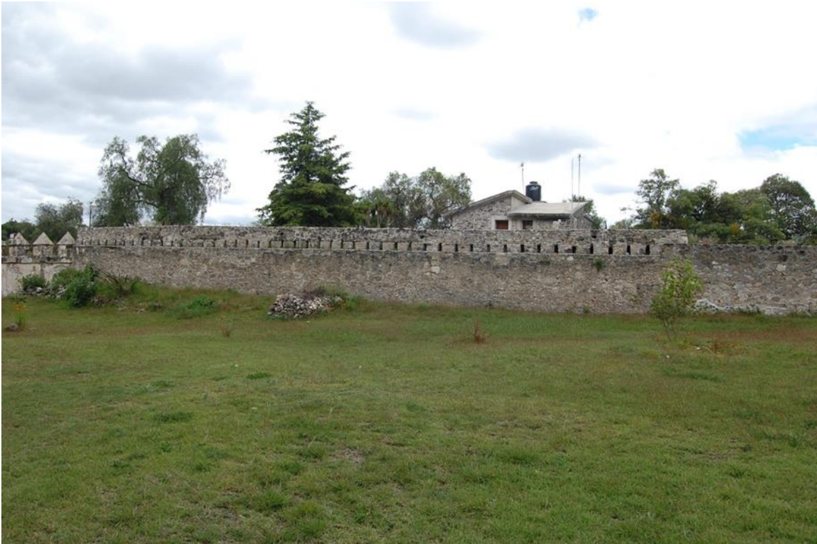
Fig. 17. Muro norte del atrio con 45 mechinales. Segmento A (fig. 16). Del autor (2011).
