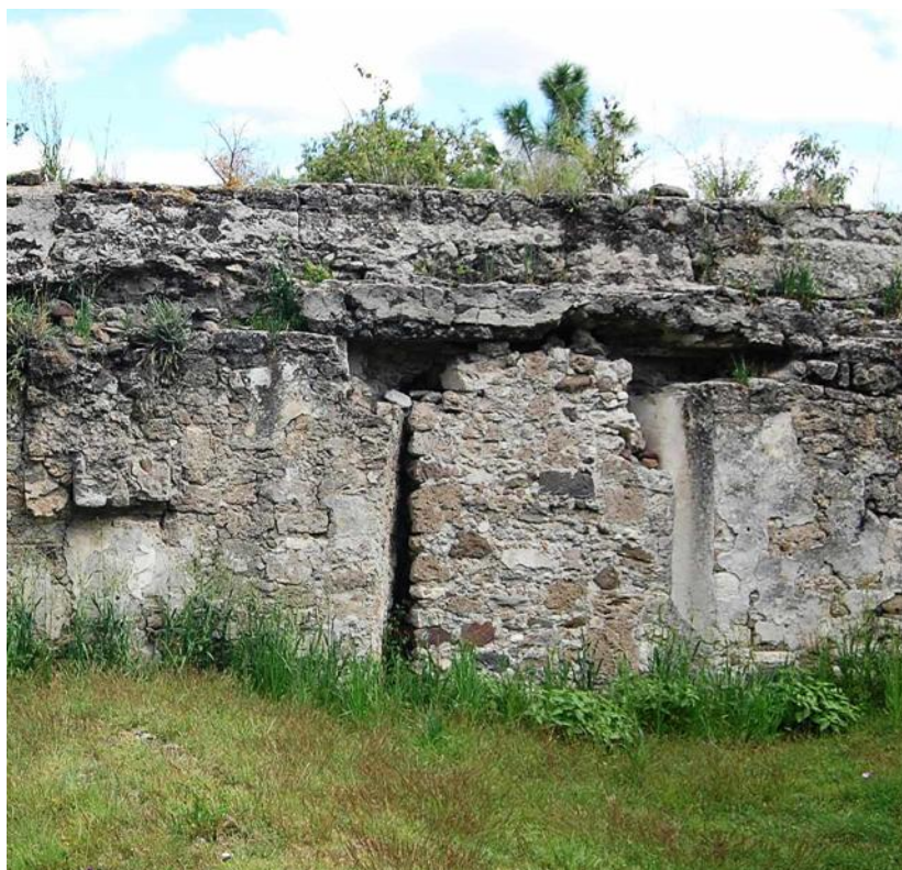
Fig. 29. Barda del atrio con huellas de tapiado. Segmento K (fig. 16). Del autor (2011).
