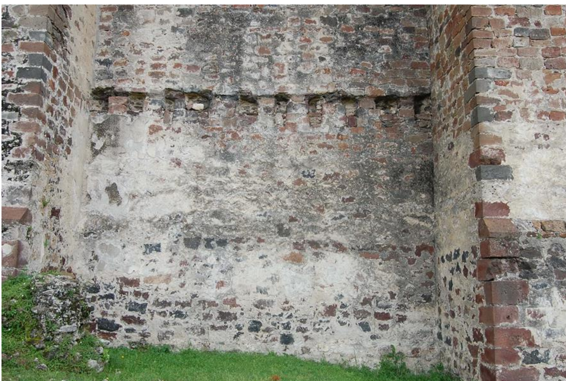
Fig. 24. Muro norte de la iglesia con 10 mechinales. Segmento G (fig. 16). Del autor (2011).
