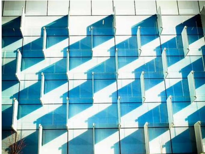
FIGURA 29. Parasoles fijos en una fachada soleada.
