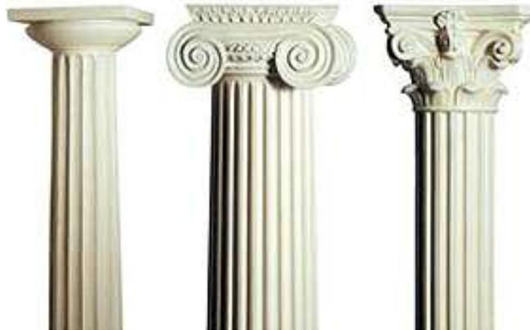
FIGURA 3. Columnas clásicas greco-romanas. Orden Dórico (izquierda), Jónico (centro) y Corintio (derecha).
