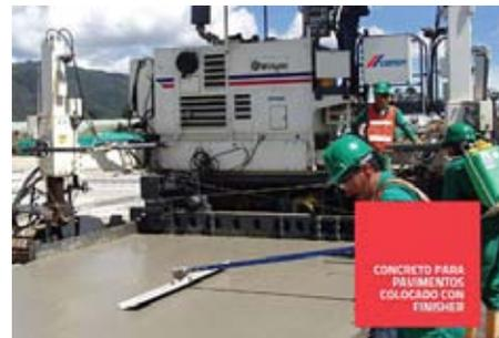
FIGURA 2.8. Pavimentadora
