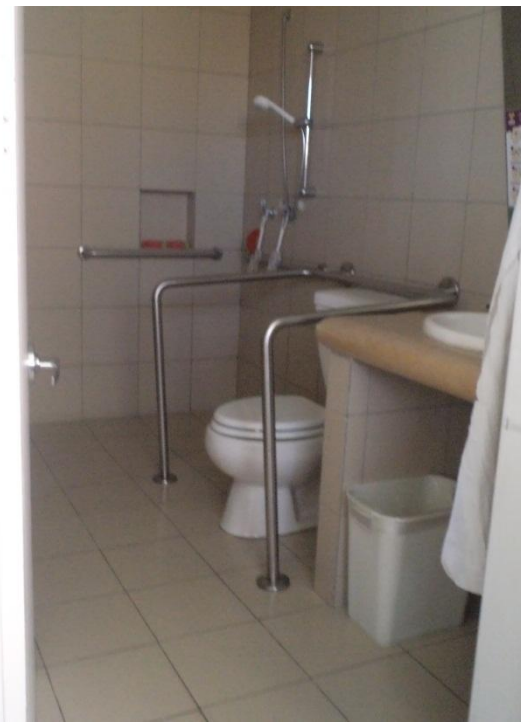
Vista de adaptación de los baños para personas con discapacidades.
