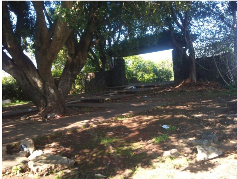
Construcción previa dentro del terreno, la cual será demolida.
