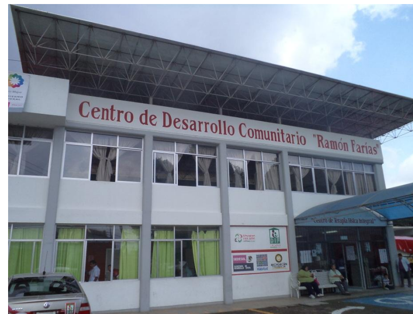
Fachada Principal CRI en Planta Baja.
