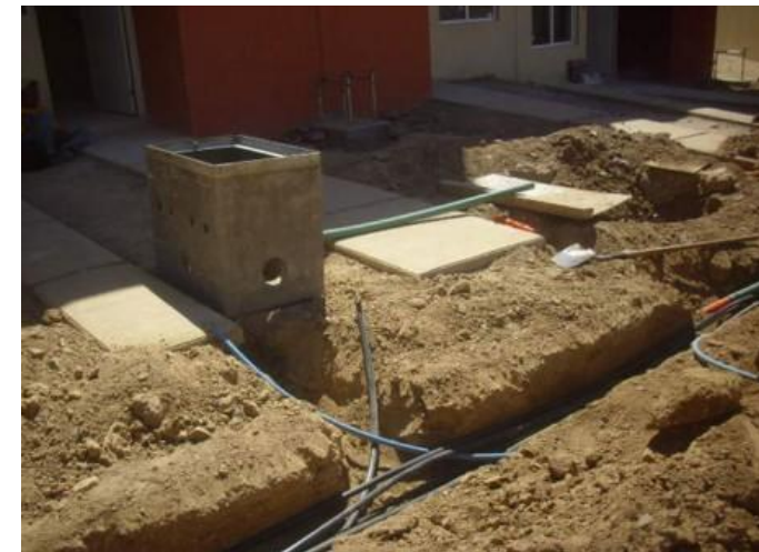
Vista de instalaciones subterráneas.
