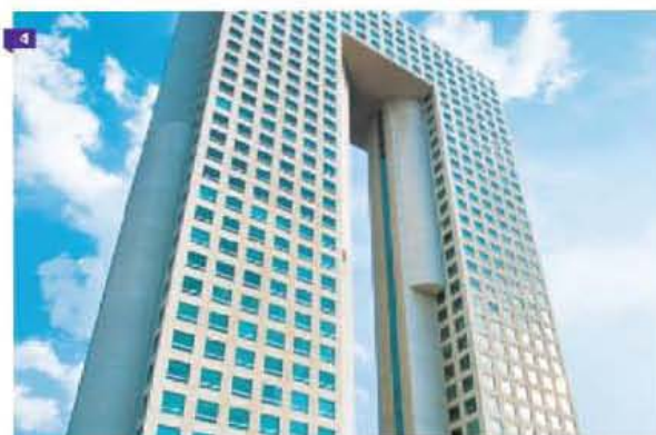
1. Foto de obra de la calle de Malabar, México, D.F. de la obra "El Jardín de la Universidad Tecnológica de México". 2. Foto de obra de la calle de Malabar, México, D.F. de la obra "El Jardín de la Universidad Tecnológica de México". 3. Foto de obra de la calle de Malabar, México, D.F. de la obra "El Jardín de la Universidad Tecnológica de México". 4. Foto de obra de la calle de Malabar, México, D.F. de la obra "El Jardín de la Universidad Tecnológica de México".
