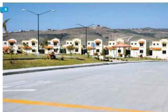
1. Puente Abasco 2. Vivienda 3es piso al 3. Hidratado - 2do piso 4. Pavimento en Uru - Cuartos del Cecc, Tijuana, B.C.
