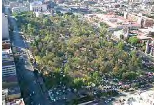
FIGURA 18. Vista del estado actual de la Alameda Central, conservando gran parte de la propuesta original de Bucareli.
