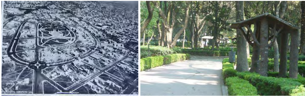
FIGURA 26 y 27. Vista aérea del Parque México en sus inicios. Estado actual del parque.
