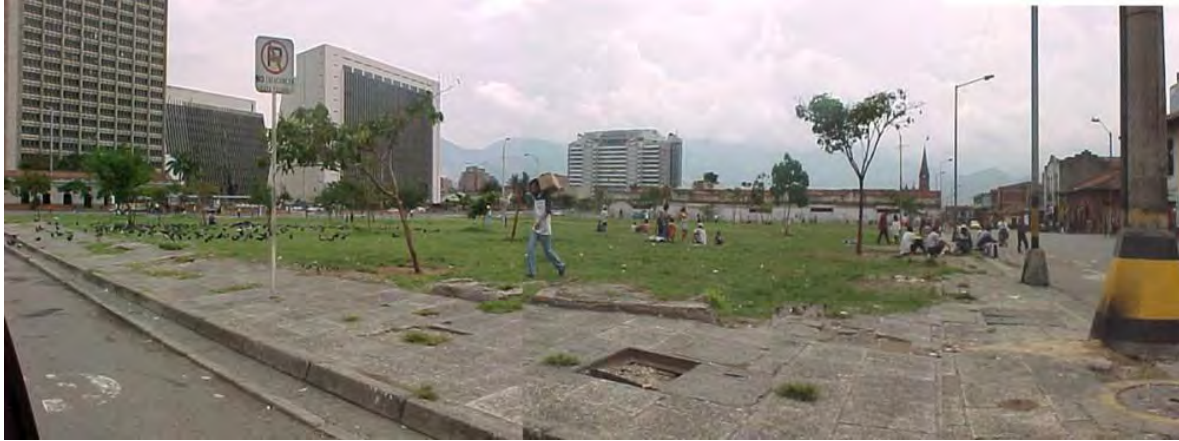
FIGURA 74. Estado de deterioro en que se encontraba la plaza Cisneros.
