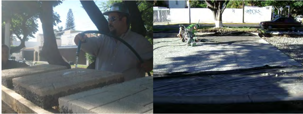
Ilustración 3.5 Ejemplos de pavimento permeable, Fuente: SIAPA, 2011
