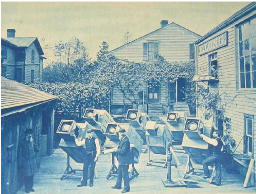
Fig. 3.10 Ampliadora solar Woodward, patentada por primera vez en 1857
