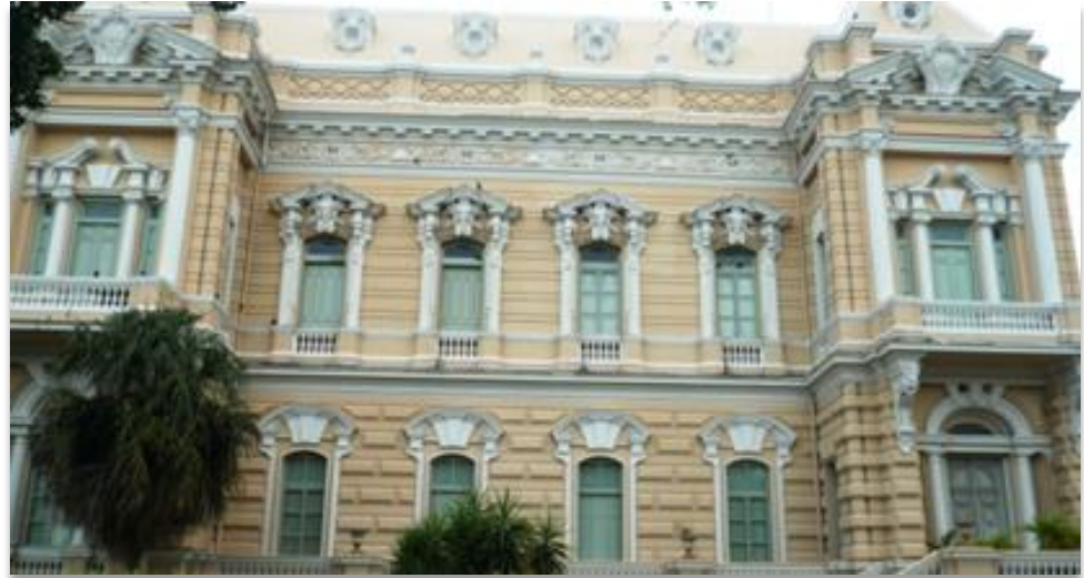
FOTOGRAFÍA 3: Casona sobre avenida Paseo Montejo
