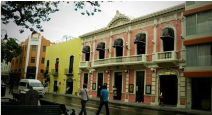
FOTOGRAFÍA 2: Avenida 61 en el centro Histórico de Mérida
