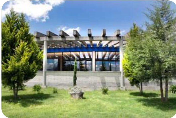
Imagen -Fachada de Talleres, cuenta con talleres los cuales tienen contacto con el exterior por vitrales, protegidos por un pergolado.
