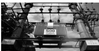
Figura 2. Debido a sus propiedades los BPCs fueron ampliamente utilizados como material dieléctrico y aislante térmico en transformadores.
