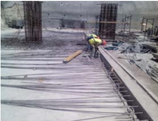
Colado de losa de cimentación hasta junta de contracción
