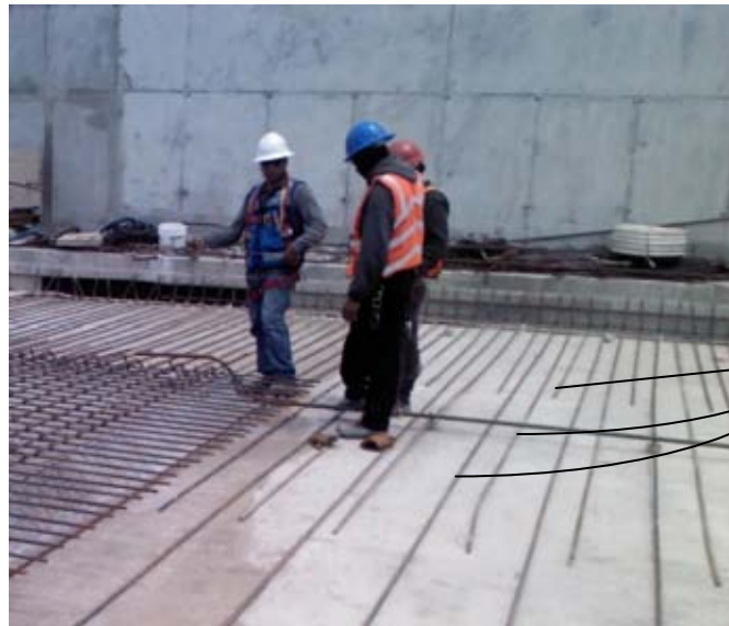
Armado lecho inferior losa de cimentación
