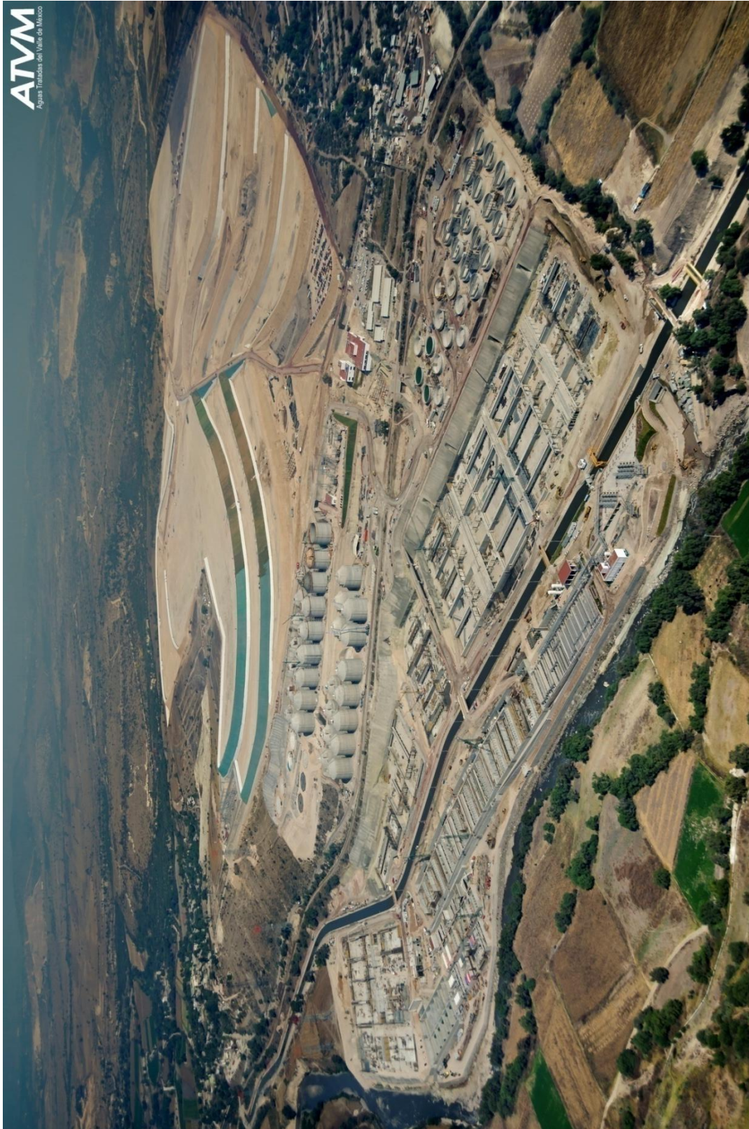
PTAR de Atotonilco
