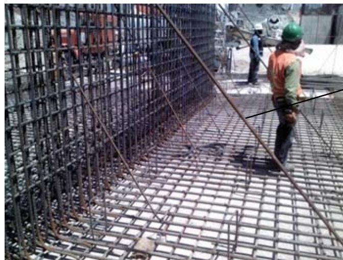
Armado vertical de acero en muros
