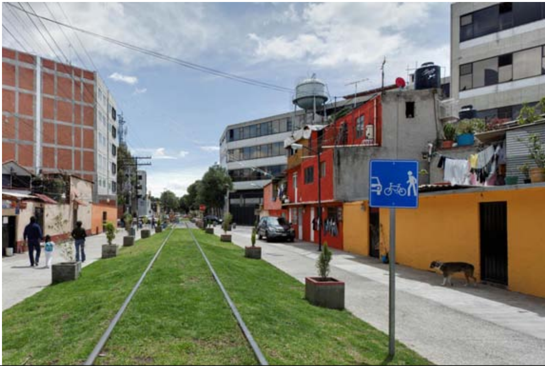
Fig. 36 Nueva utilización de señalización para el uso de las vías y delimitación de las mismas. Entre FFCC Cuernavaca y lago Como
