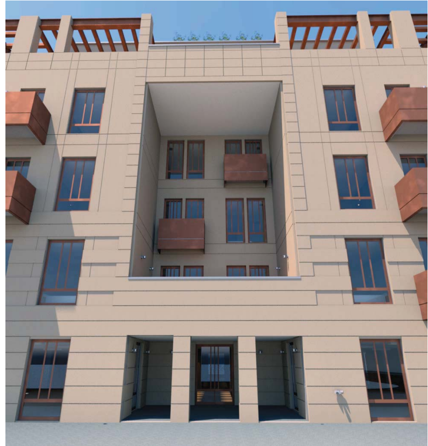
Fachada de la calle de J. Torres Bodet donde se encuentra el pórtico de acceso principal.
