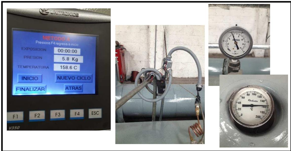
***Figura 3.5. Además de contar con los sensores electrónicos como muestra la imagen se cuentan con manómetros y termómetros estándar para un mejor monitoreo del proceso***
