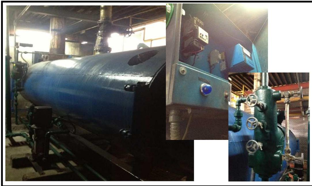
***Figura 3.13. La caldera es el equipo que se encarga de suministrarle vapor a los autoclaves por tal razón es uno de los equipos claves dentro del proceso de fabricación del producto***
