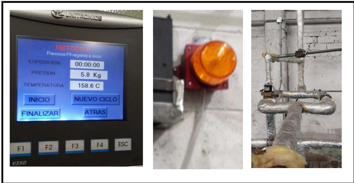
*Figura 3.4. Pantalla de monitoreo, las válvulas que se activan y la alarma que suena cuando finaliza un ciclo completo*
