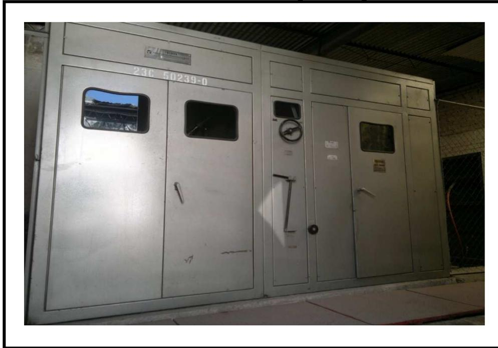
*Figura 3.12. Subestación eléctrica TEIMSA voltajes de trabajo 440 V y 220 V, también cuenta con su tablero principal y su banco de capacitores*
