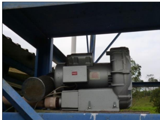
Figura 3.12 Fotografía del modelo de aireador utilizado en el módulo de producción acuícola del CEIEGT, sus características eléctricas se detallan en la tabla 4.1
