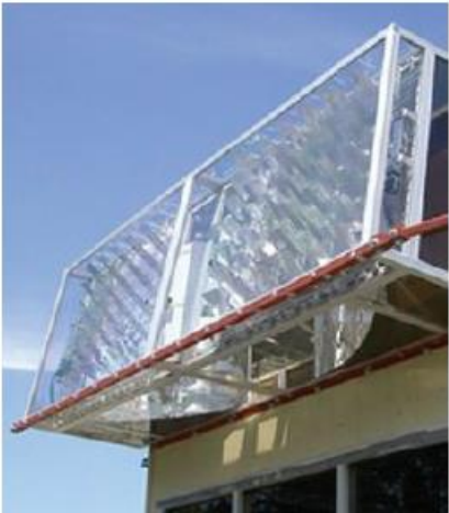
Fig. 23. Sistema de iluminación solar Canopy. (Mayhoub & Carter, 2011)
