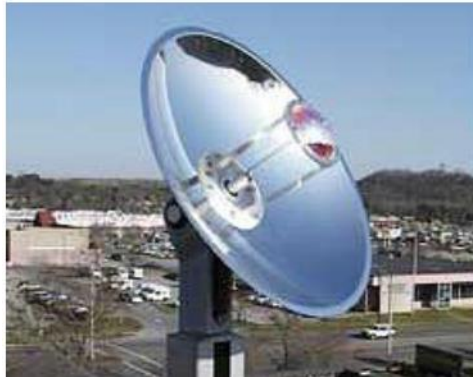
Fig. 21. Captador de luz natural de un tubo de luz natural (Mayhoub & Carter, 2011)
