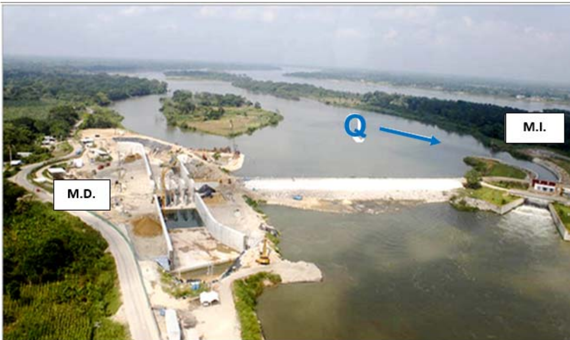
Figura IV. Funcionamiento de la estructura durante la construcción del canal de MD
