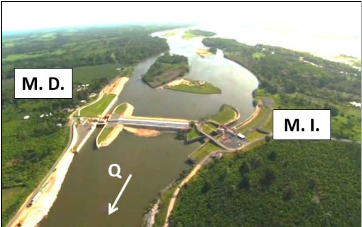
Figura 1.4 Estructura de control El Macayo
