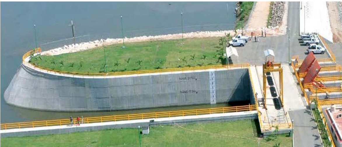
Figura 4.8b Escala para leer H_p en el canal de la margen derecha
