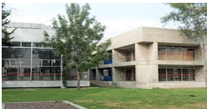
Fig. 4 Fotografía de la Biblioteca del Campus I, vista del lado norte con la ampliación
