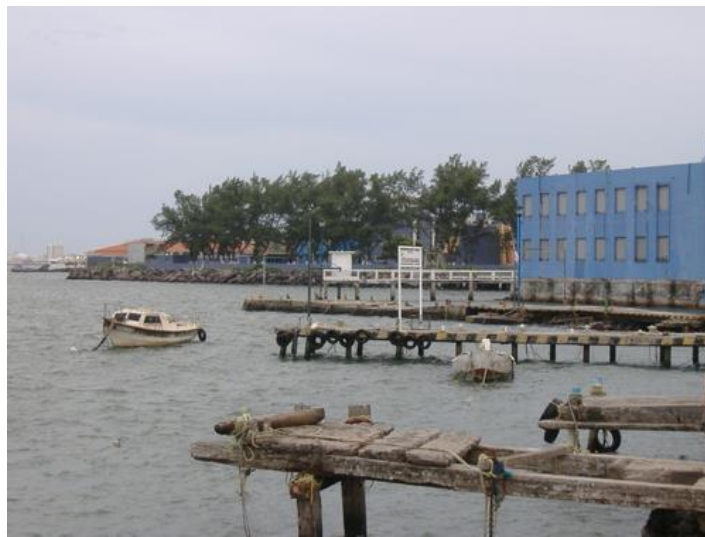
Figura 12. Muro de Pescadores, ubicado en la planicie del Arrecife Hornos.
