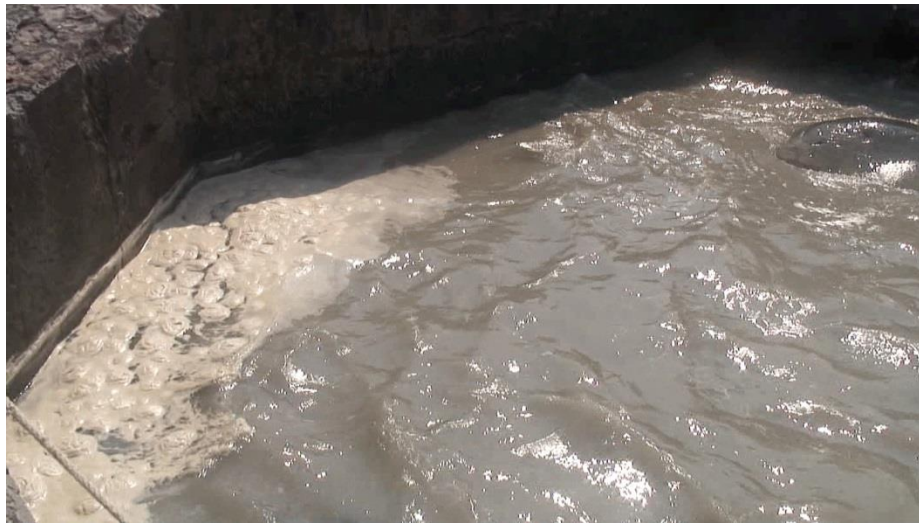
Figura 16. Vertimiento de desechos durante la construcción de la Marina Veramar.
