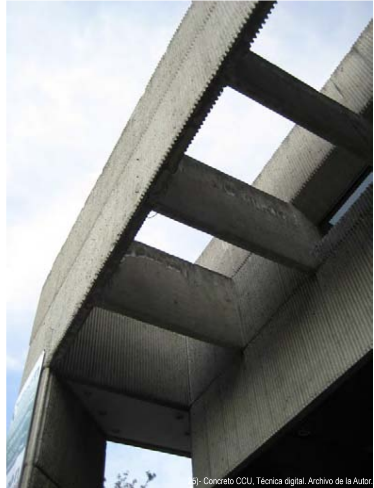
25)- Concreto CCU, Técnica digital. Archivo de la Autor.
