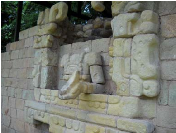
Figura 13. Fachada de la estructura 9N-82 de Copán (Fotografía del autor).
