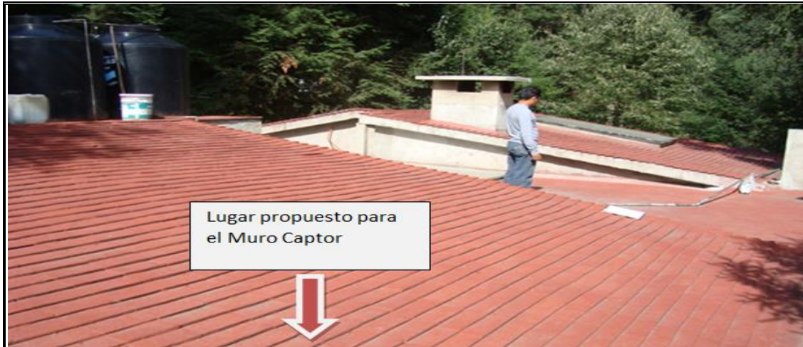
Figura 5.9 Lugar propuesto muro 1
