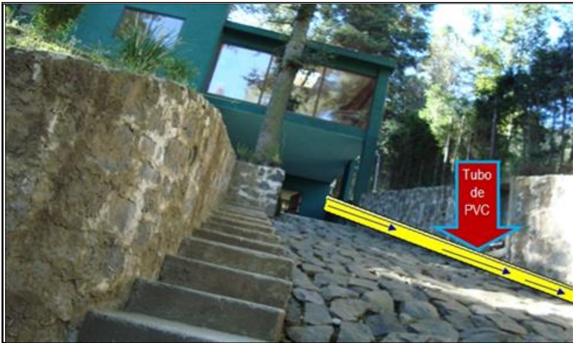
Figura 5.41 Instalación de tubería de PVC rumbo al almacenamiento 02
