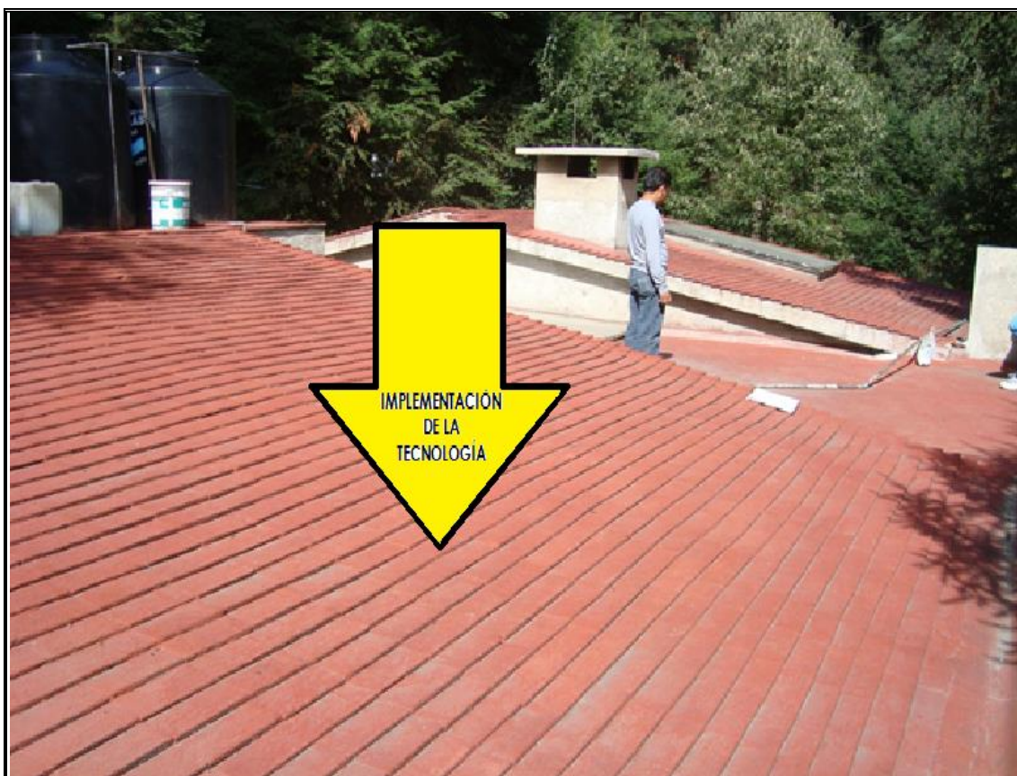
Figura 5.24 Techo de la casa vista II
