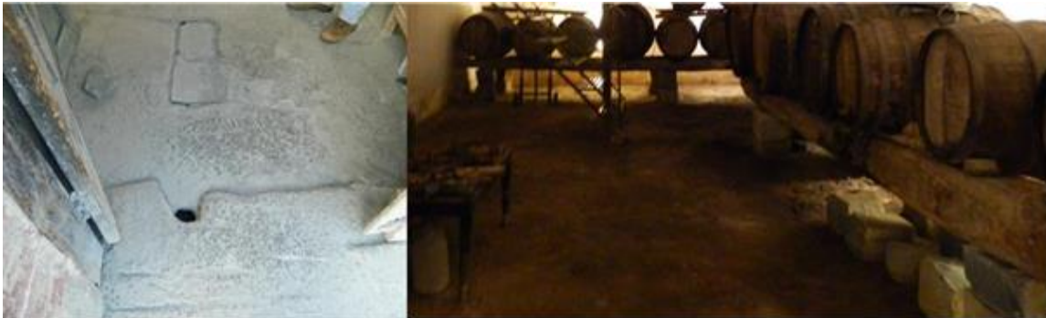
Fotografía 16 Detalle de pisos y pavimentos a base de tierra y piedra; ejemplos de Bodegas Perote y Vesubio, Capturas Abril 2014, Alejandra Gtz.
