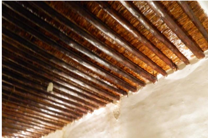
Fotografía 10 de sistema constructivo de la bodegas, construidas con varas y morillos. Tomada por Alejandra Gtz en el interior de la Bodega Vesubio; Marzo 2014
