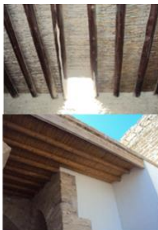
Trabajado en obra
