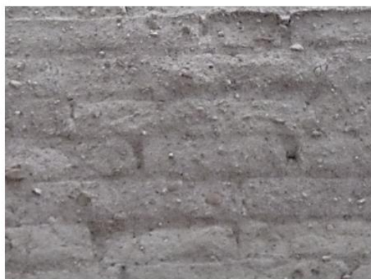
Trabajado en obra
