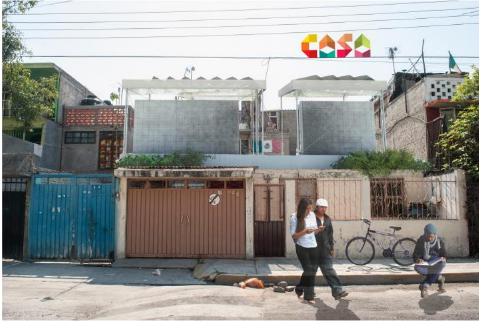
Fig. I-2. En esta imagen, se muestra la capacidad de CASA de poderse instalar en cualquier espacio disponible para el sistema. En este renderizado se ejemplifica su implementación en la Unidad Habitacional Vicente Guerrero, Iztapalapa, D. F. [8].
