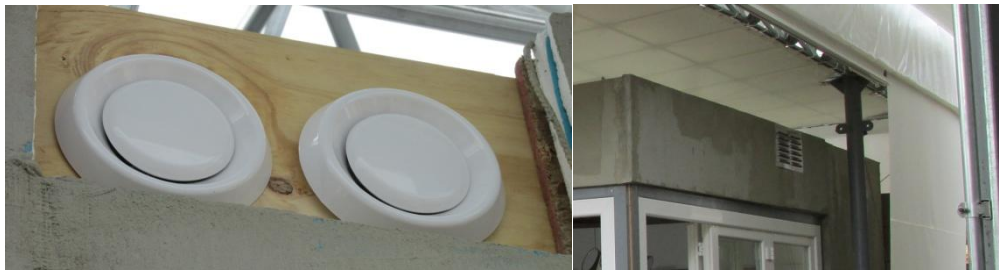
Fig. V-8. Instalación de componentes exteriores del sistema de ventilación de CASA-UNAM. Las barreras entre los difusores quedaron ocultas por la rejilla exterior.
