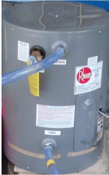
Fig III-9. El calentador de agua eléctrico de depósito de respaldo Rheem 89VP15S de 57 l.
