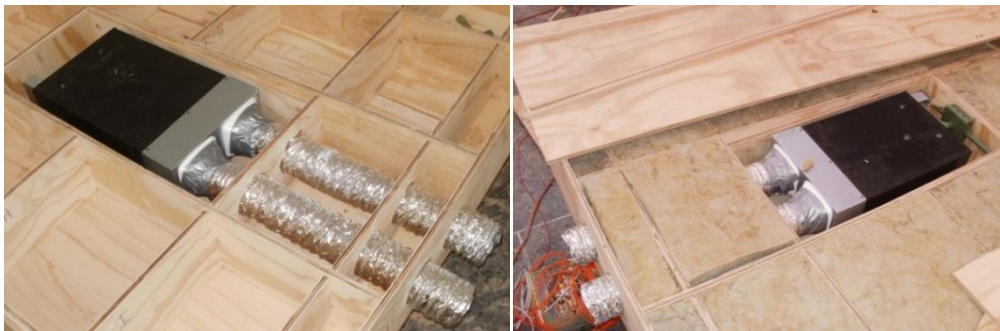
Fig. V-6. Proceso de ensamblaje de los ventiladores.
