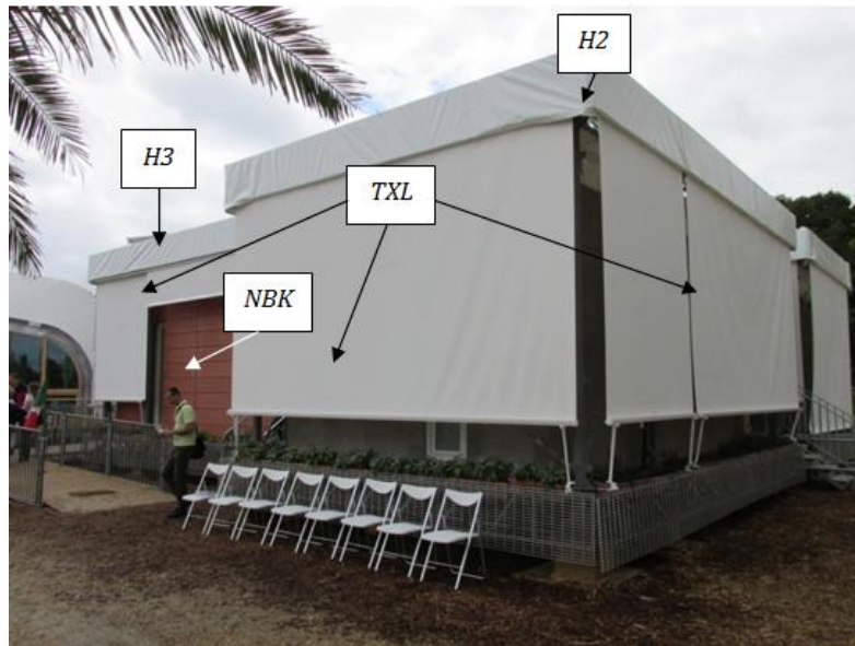
Fig. V-9. Vista Nor-poniente de CASA-UNAM desde la rampa de acceso para visitas con los textiles (TXL) puestos y exhibiendo la fachada ventilada colocada (NBK) únicamente en el muro norte del habitáculo privado (H3).
