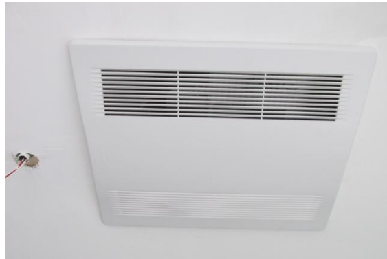
Fig. V-7. Instalación de las rejillas interiores en CASA-UNAM.
