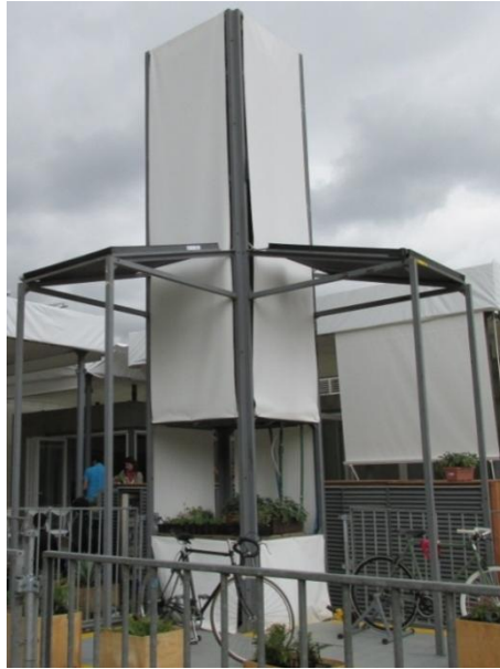
Fig. V-5. Forma en la que finalmente quedó construida la torre hidráulica después de forrarse para evitar la incidencia del sol directa sobre los depósitos de agua.
