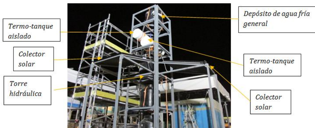
Fig. V-4. Instalación del sistema solar de ACS para CASA-UNAM en competencia. Las cintas naranjas alrededor de los termo-tanques son los cinchos de sujeción.
