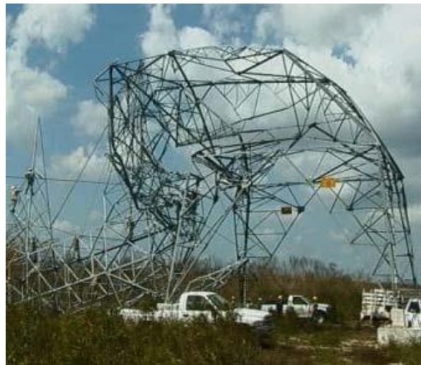
Figura 4. 11 Falla por ruptura de algún cable (Gaceta electrónica UNAM, 2012).
