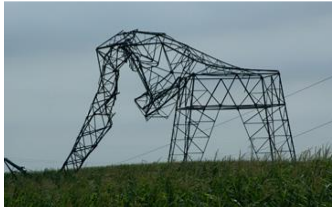
Figura 4. 10 Falla en elementos estructurales por fuerzas de grandes proporciones (Runestone Electric Association, 2011).
