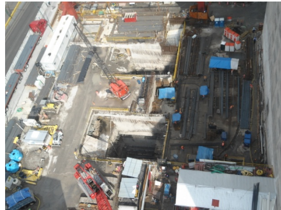
Fig. 2.q. Plataforma de trabajo con 2 lumbreras
