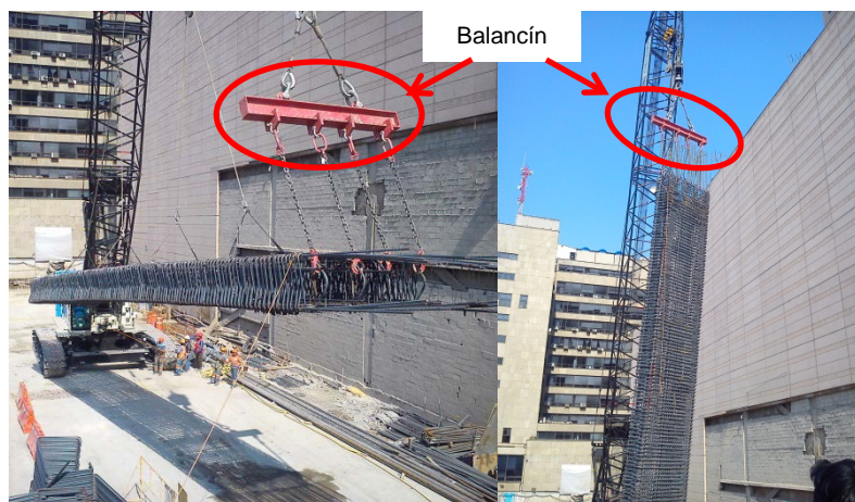
Fig. 4.k.1. Izado de armado de una posición horizontal a vertical.
