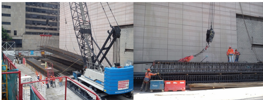
Fig. 4.i.1. Grúa con orugas y gancho para el izaje de la jaula.
