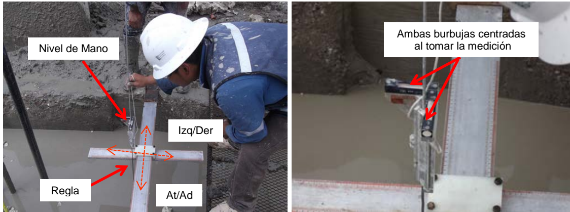
Fig. 4.a.1. Regletas en forma transversal al brocal con nivel de burbuja en ambos sentidos.
