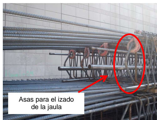
Fig. 4.h.1. Elementos para izar el armado.
