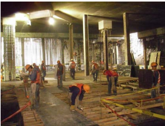
Fig. 2.t. Colocación de cimbra para una losa
