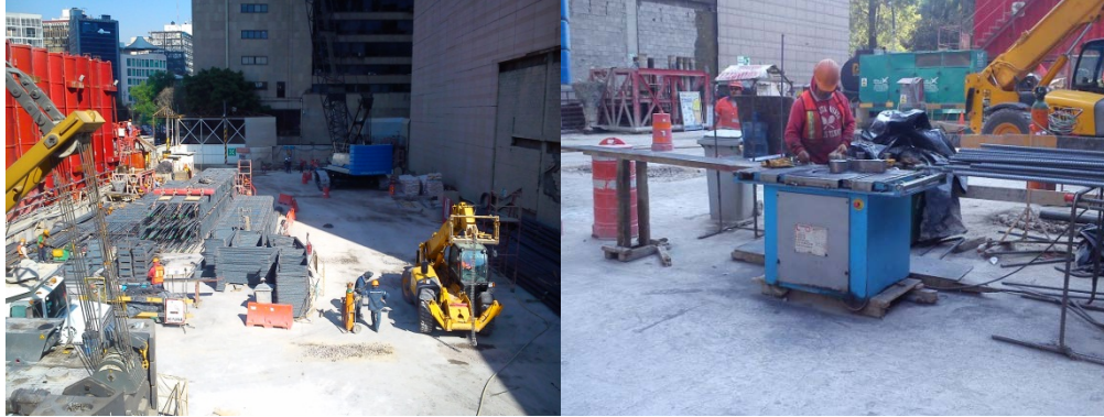
Fig. 4.e.1. Zona de corte y habilitado de acero.
