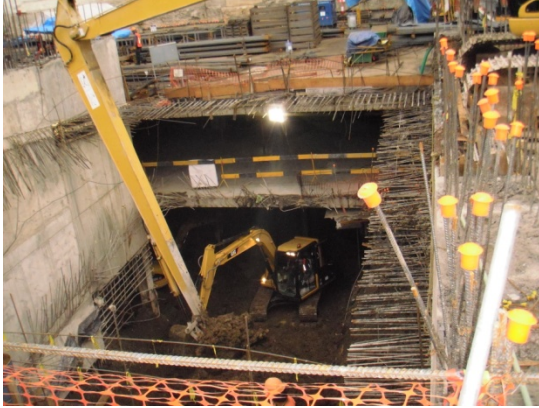
Fig. 2.r. Excavación hasta la primera losa a construir
