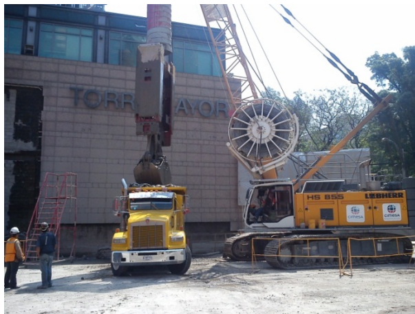
Fig. 4.m. Cargado de camión con material de excavación.
