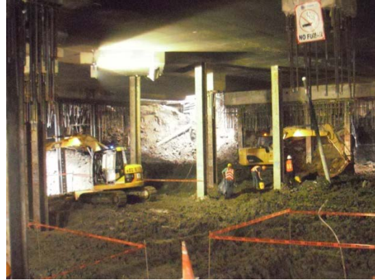
Fig. 2.s. Excavación con equipos minis
