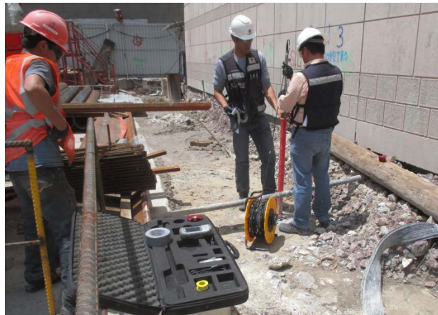
Fig. 4.z.1. Descenso de la sonda para la toma de lecturas.
