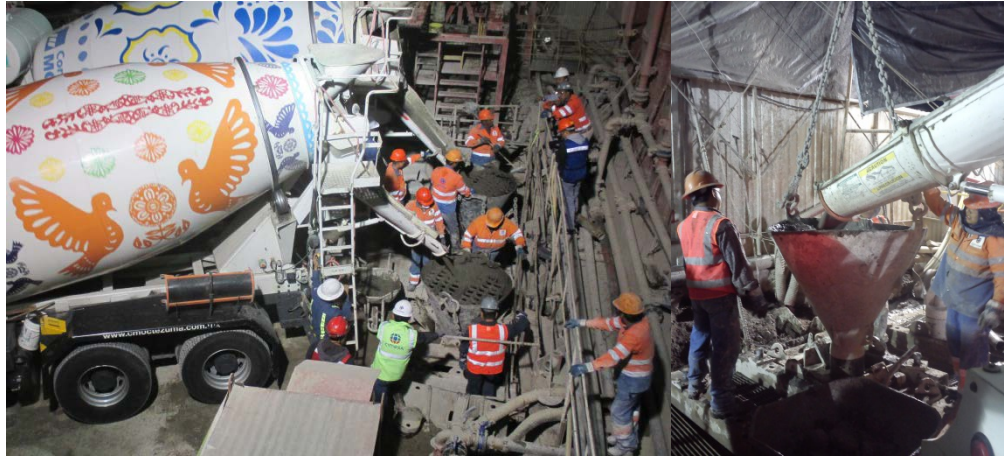
Fig. 4.u.1. Vaciado del concreto sin interrupción.
