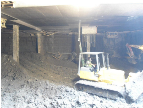
Fig. 2.p. Excavación bajo losas previamente coladas
