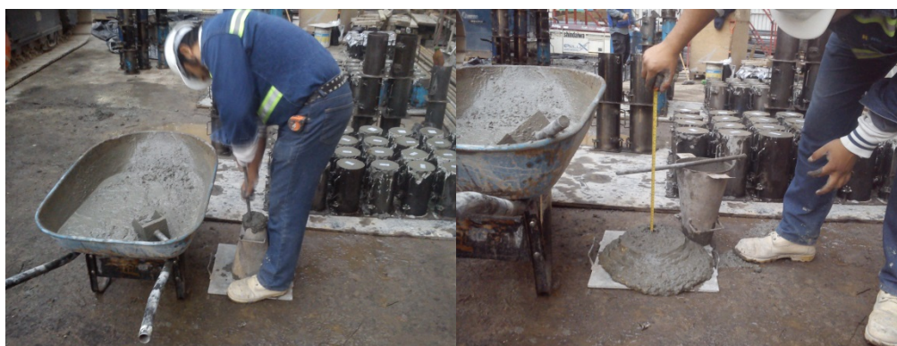
Fig. 4.s.1. Prueba de revenimiento, el rango para muro Milán convencional será de 18 cm a 22 cm.
