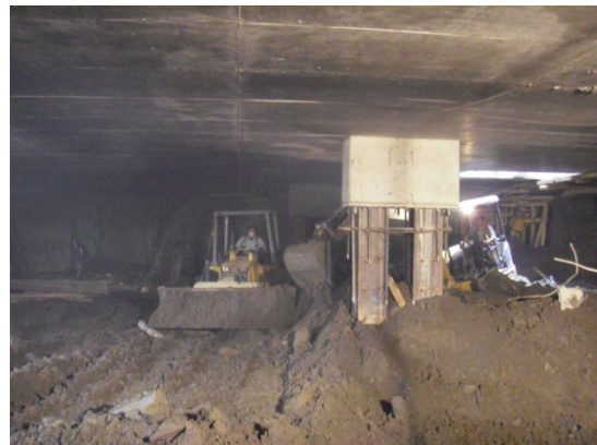
Fig. 2.u. Perfiles embebidos en concreto
