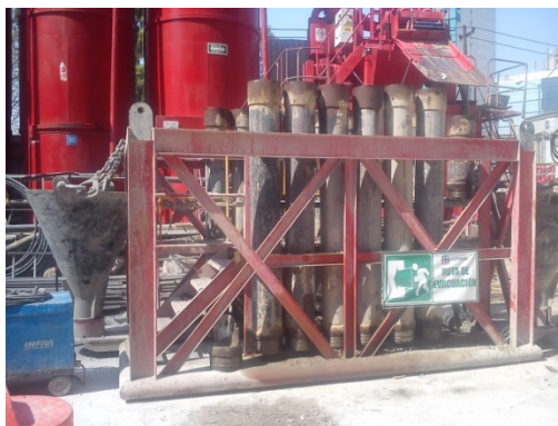
Fig. 4.t.1. Tubería Tremie.
