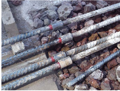
Fig. 4.g.1. Conectores de varilla con roscado.
