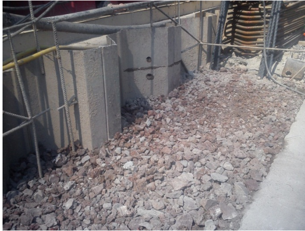
Fig. 4.b. Zanja con brocal de concreto, rellena con material de excavación.
