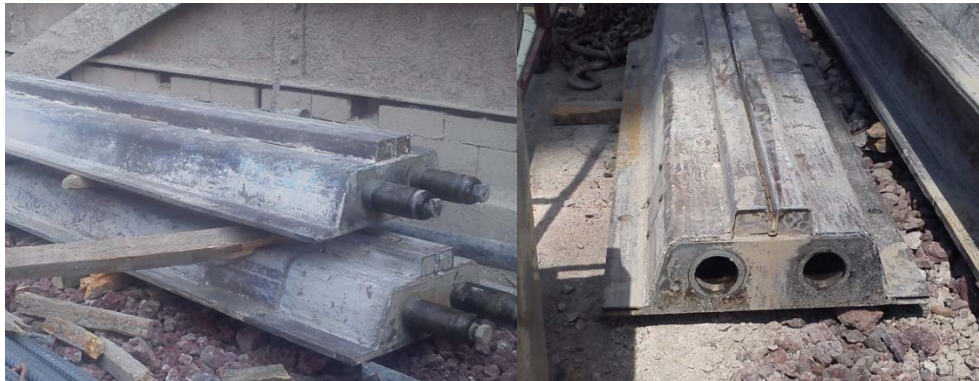
Fig. 4.p.1. Junta metálica con sistema de macho y hembra.
