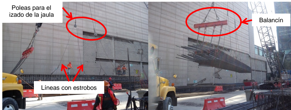
Fig. 4.j.1. Grúa con poleas y balancín para el izaje de la jaula.
