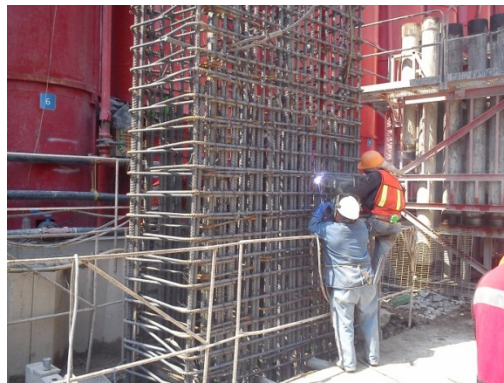
Fig. 4.n.1. Colocación de estribos uniéndolos mediante una soldadura a la jaula.
