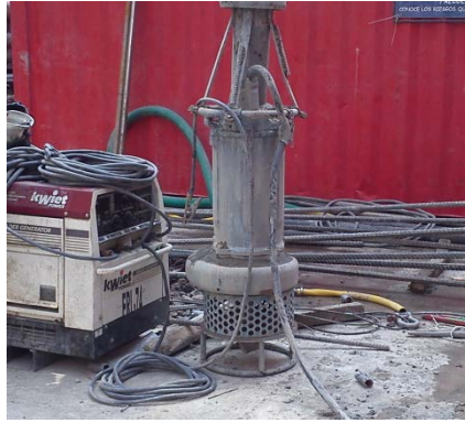
Fig. 4.w. Bomba sumergible para desarenar el lodo bentonítico.
