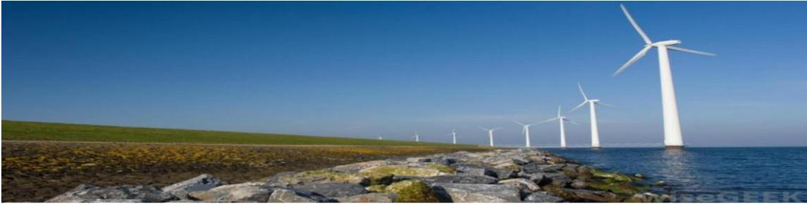
**Figura 50.** Instalación eólica, en área costera sin presencia de obstáculos
