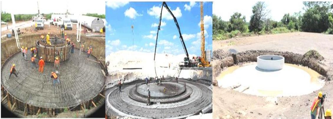
**Figura 59.** De izquierda a derecha, se muestra la construcción de la cimentación con empleo de zapatas, así como la fabricación de la plataforma de montaje para la instalación del aerogenerador.
