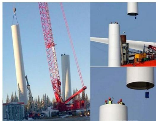
**Figura 64.** Alzado y armado de torre para aerogenerador. “Izado de torre”. Imágenes tomadas del sitio. [http://www.profesorenlinea.cl/ecologiaambiente/Eolico\\_Parque\\_Marino.htm](http://www.profesorenlinea.cl/ecologiaambiente/Eolico_Parque_Marino.htm). (Fecha de actualización 15 de agosto del 2014).
