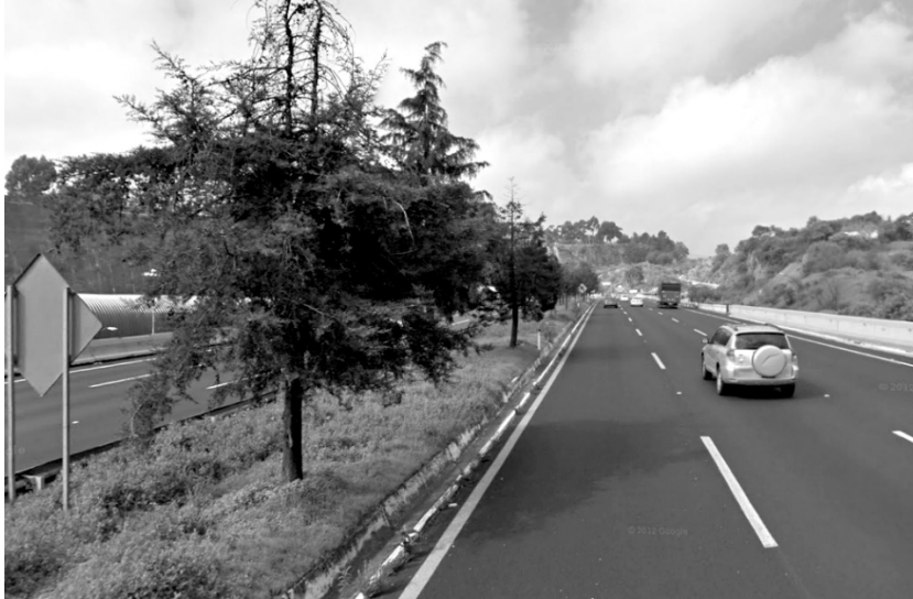
Foto 14 Vialidad regional, Autopista México-Toluca
