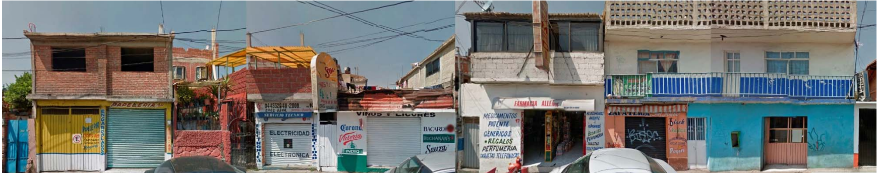
Foto 19 Fachadas estado actual calle Allende, San Mateo Tlaltenango
