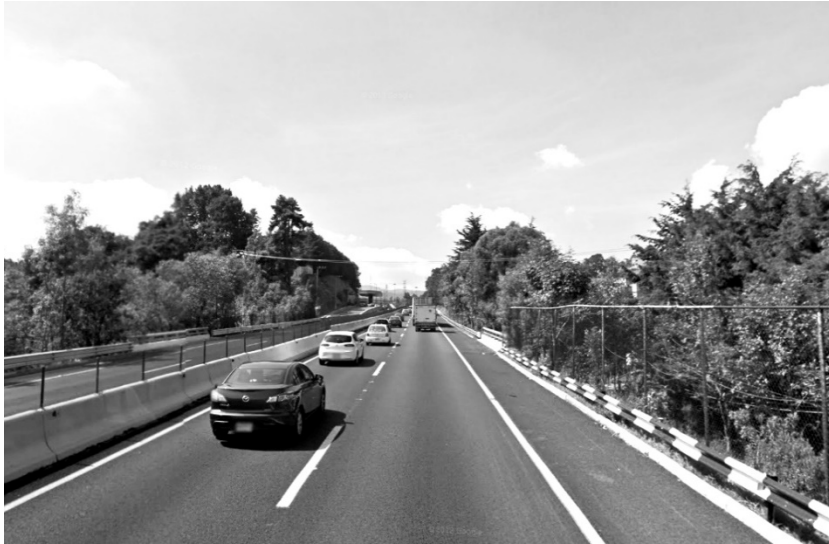
Foto 15 Vialidad regional, Autopista Chamapa-Lechería
