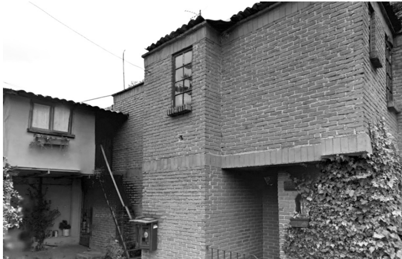
Foto 6 Vivienda progresiva en etapa de acabados
