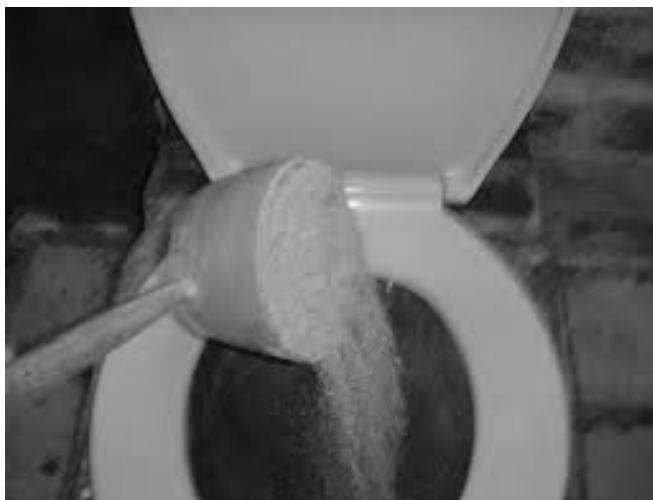
Imagen 13. Revoltura de tierra-cal para el Baño Seco
