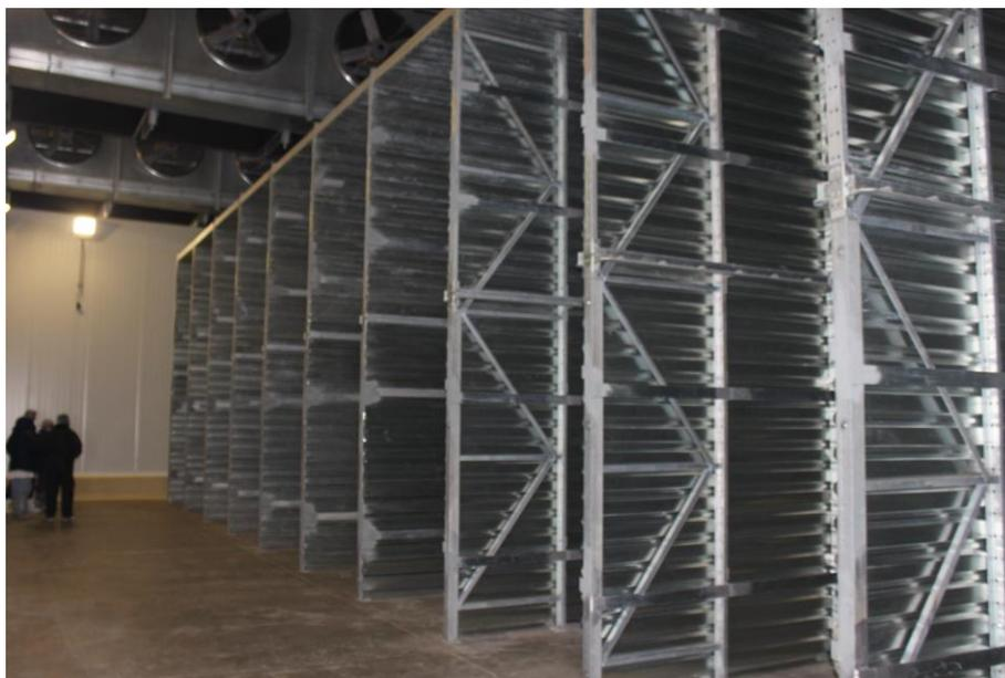
*Figura 50.* Vista interna del congelador por ráfaga de aire “*blast freezer*” con los 12 túneles de congelación.
