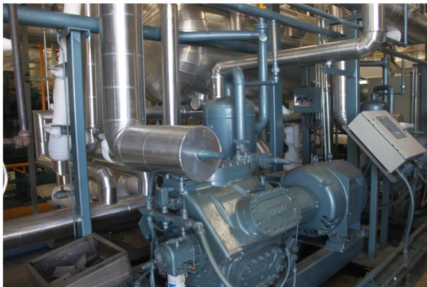
*Figura 17.* Compresores del paquete de CO<sub>2</sub>.
