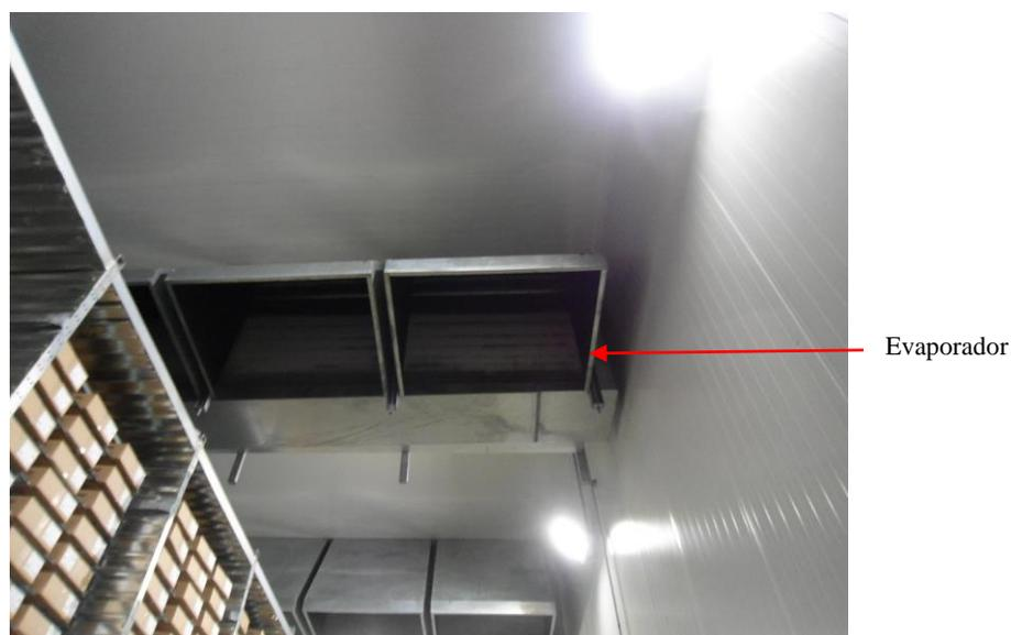
*Figura 22.* Evaporadores sobre los túneles de congelación.
