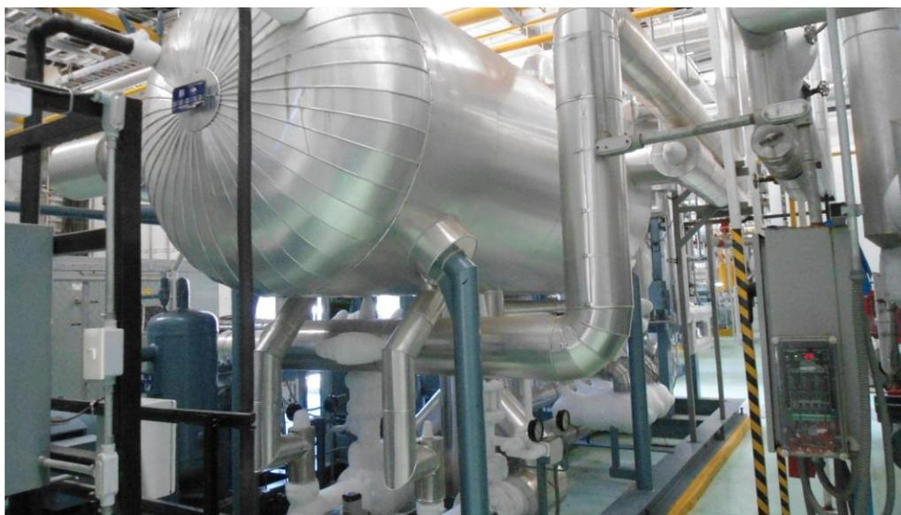
*Figura 15.* Unidad recirculadora horizontal, sistema por bombas.
