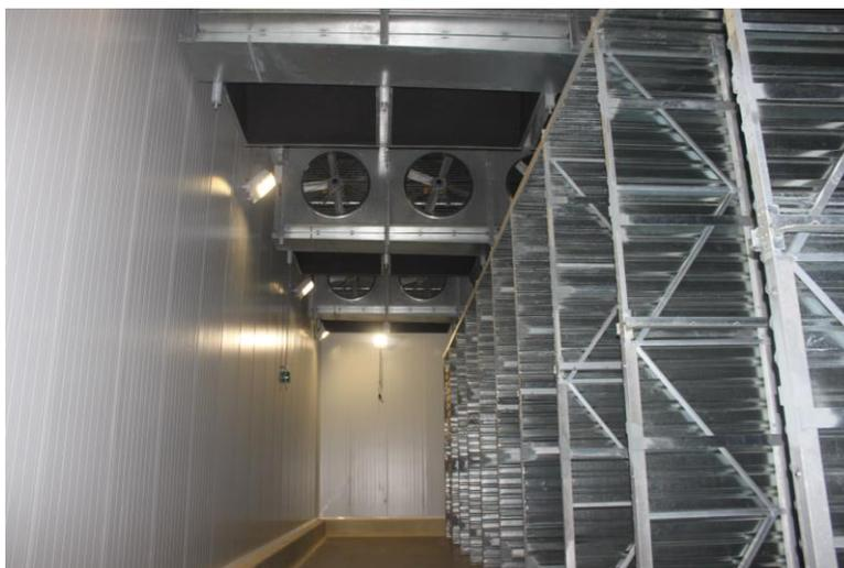
*Figura 19.* Vista del congelador por ráfaga de aire “blast freezer” con los túneles vacíos.
