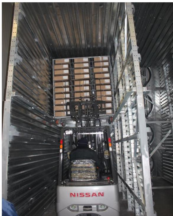
*Figura 20.* Vista de un túnel de congelación mientras es abastecido con producto envasado.
