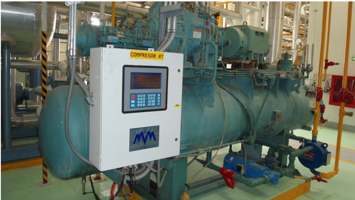
*Figura 12.* Compresor de tornillo de la primera etapa de compresión.
