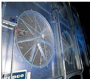
*Figura 47.* Evaporadores con potentes ventiladores para generar ráfagas de aire (GEA, 2012).
