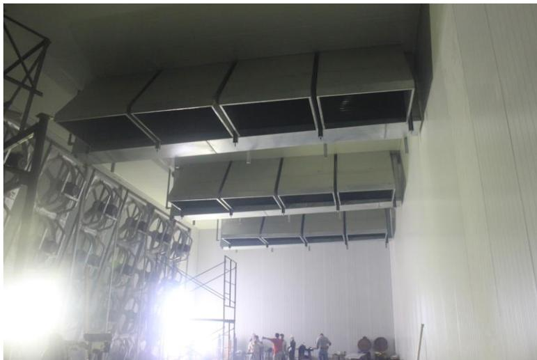
*Figura 52.* Evaporadores de CO<sub>2</sub>.
