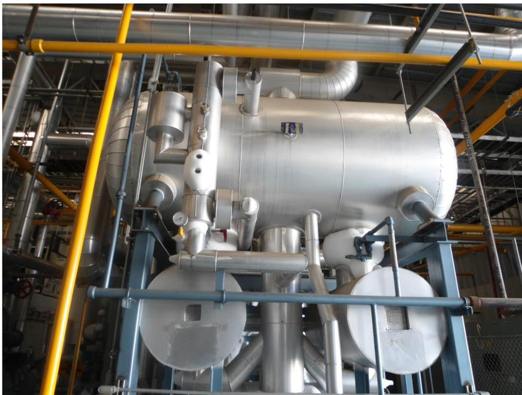
*Figura 13.* Paquete de producción de frío mediante CO<sub>2</sub>.
