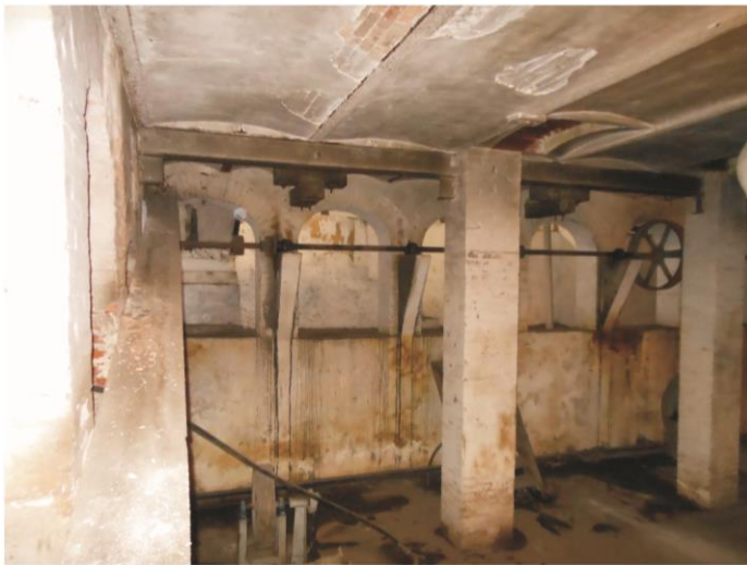
23. Imagen de la nave de secado artificial, donde se observa el sistema constructivo de viguetas y bóvedas con enladrillado sobre una viga “I” que funciona como larguero y de apoyos verticales pilares de tabique con alma de acero. (Junio 2012).
