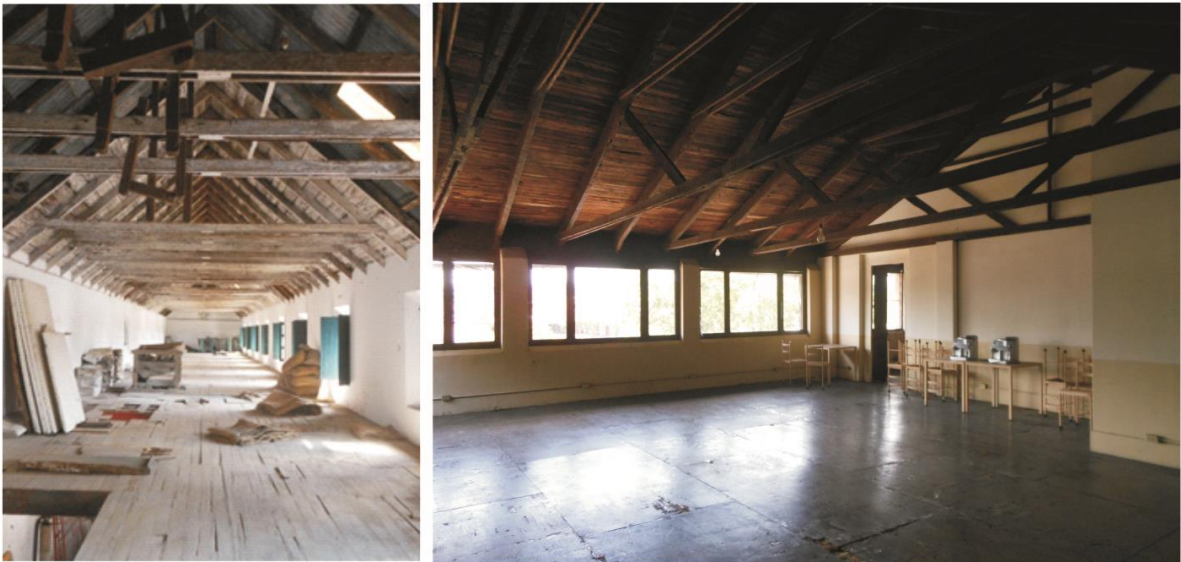
24. Nave de desmanchados en planta alta del Beneficio “Roma”/Nave de desmanchados en la parte superior del terreno en el Beneficio “La Mata”. En ambas imágenes se observa una cubierta a dos aguas con estructura de madera de par y nudillo y entrepiso de madera. (Enero 2013) Fuente: Ana Daría Torres.
