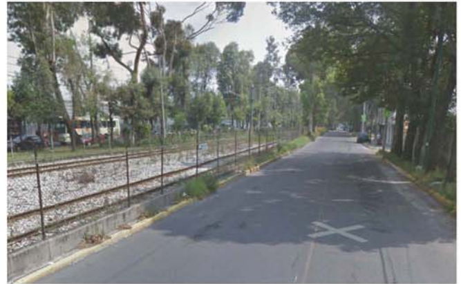
No existe muro de contención entre la calle y las vías del tren ligero
