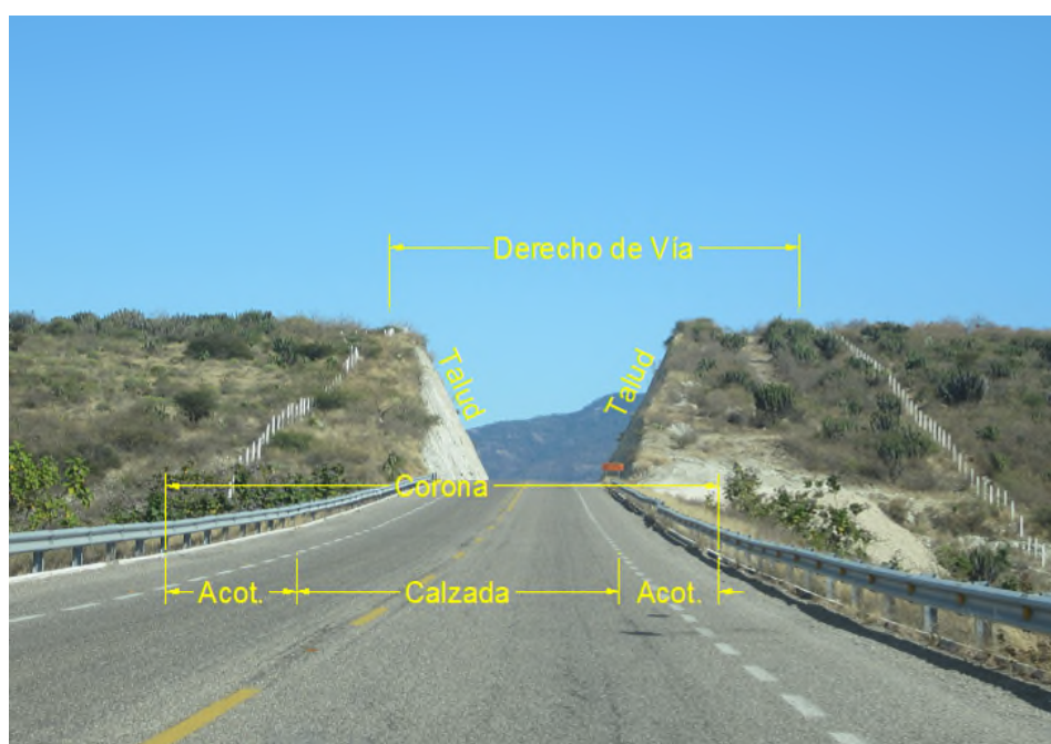
III.4.6.1. Elementos de la sección transversal de una carretera tipo A2
