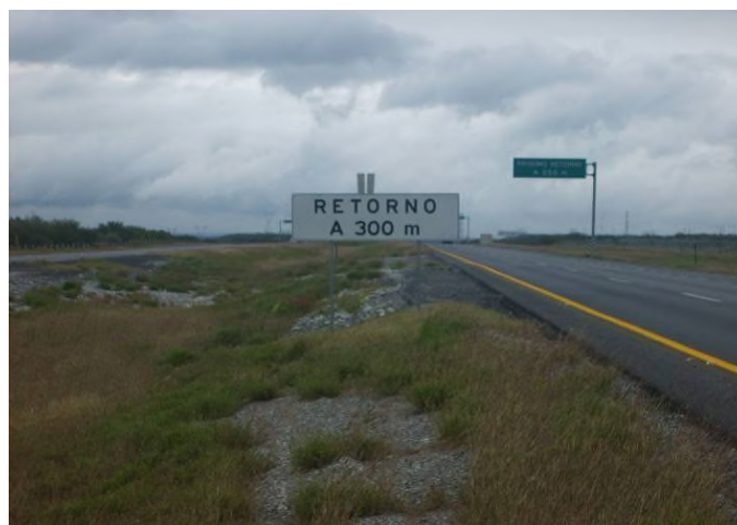
Figura V.2.4.1. Vista de la mediana en la Autopista 40D
