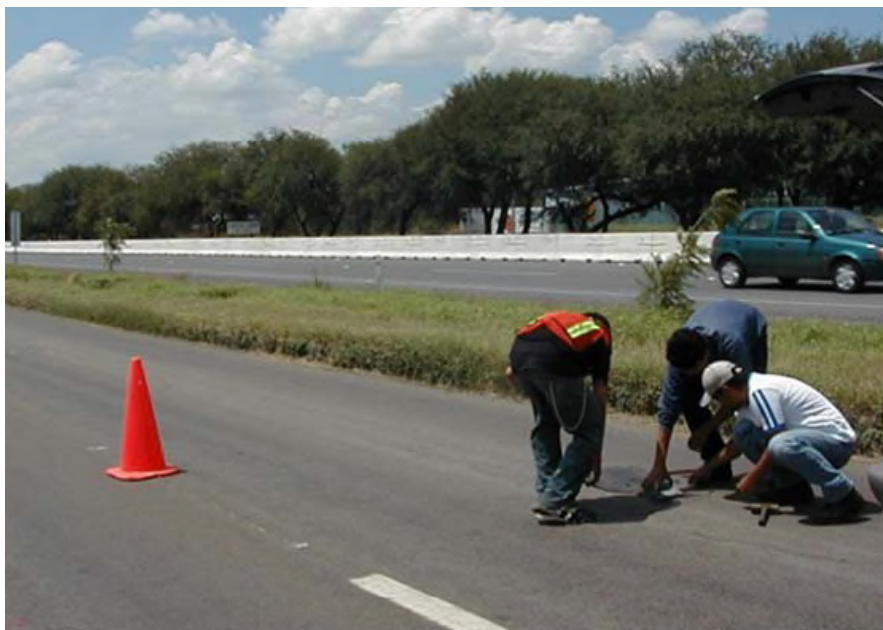
Figura II.5.1.2.1. Instalación de placas aforadoras para estudios temporales.
