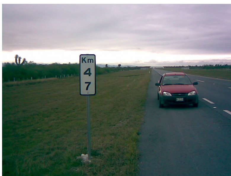
Figura V.2.67.1. Vista del derecho de vía cuerpo A.
