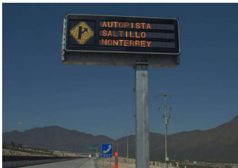
Figura IV.3.5.18. Señal de mensaje cambiable tipo bandera (SID-13) en el panel luminoso se muestra la señal SP-19 Salida.
