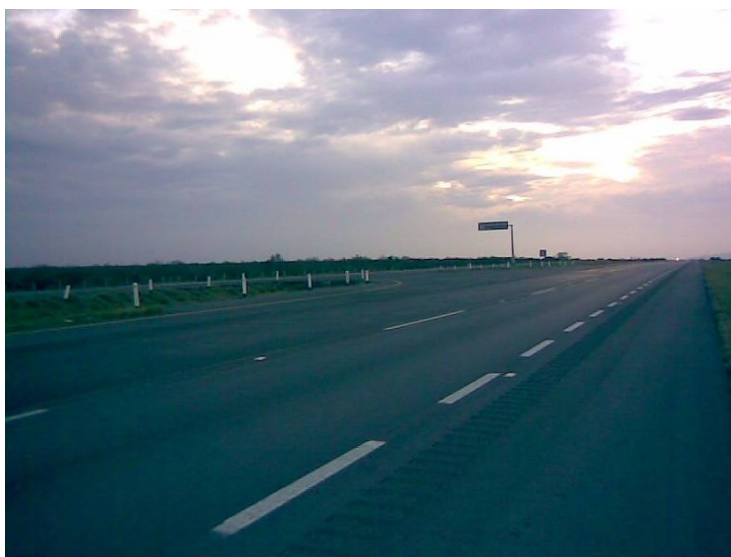
Figura V.2.5.1. Vista general del Retorno 3 km 57+650
