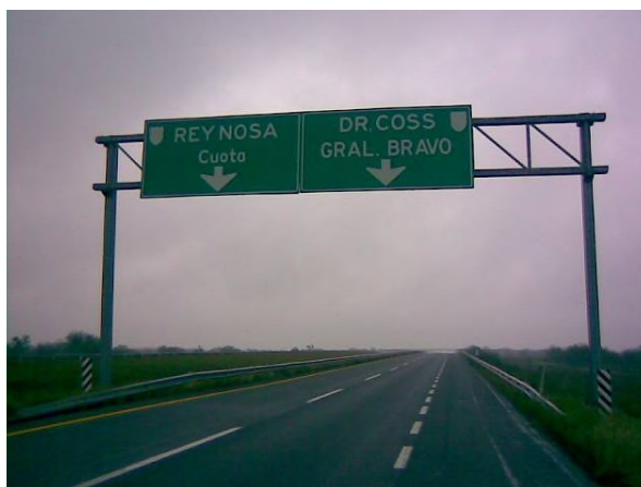
Figura IV.3.4. Ejemplos de señal elevada (puente)
