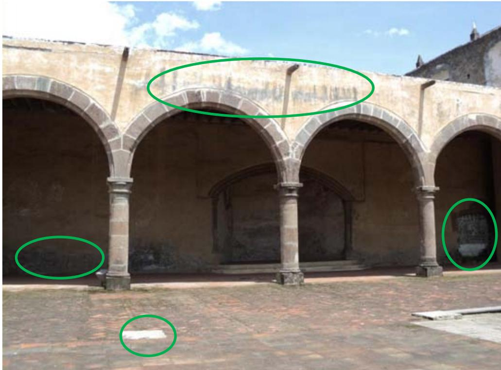
El retiro y consolidación de elementos de vegetación microscópica y macroscópica nociva se realizará a base de poda e inyección de raíces con jeringa y biocidas en raíces de juntas que se hayan adherido a los sillares.
