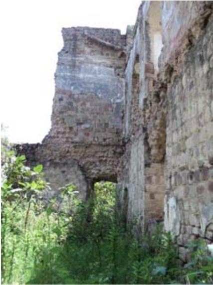
*Foto 59 Daño de muros en claustro de convento de Tepeyanco, perdida de material y desviases*
