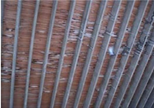
*Foto 45 Vigería de concreto en sustitución de la de madera.*
