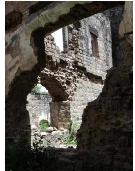
Muchas jambas de los arcos de acceso se perdieron y han hecho que se deformen los arcos hasta el grado de derrumbe, los desplazamientos en muros y derrumbes son inminentes en gran parte de los muros interiores superiores, el piso original es de ladrillo en forma de petatillo pero se ha perdido un gran porcentaje de este y se encuentra totalmente cubierto por vegetación superior dañina.
