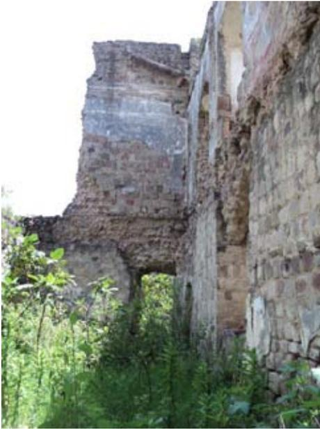
*Foto 50 Desgaste en muros y arcos*
