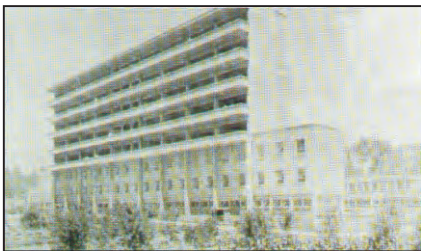
Fachada Oriente del Sanatorio Hospital Manuel Gea González", 1947
