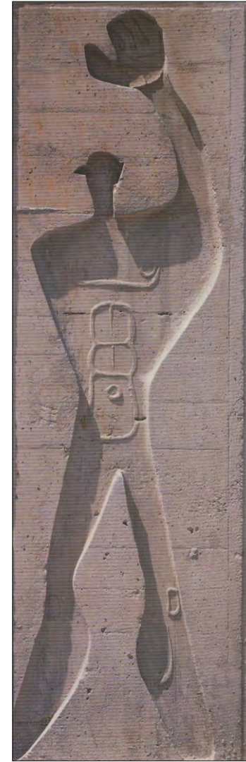
Ilustración 21. Detalle del Modulor , colado en concreto en la Unidad Habitacional, Marseilles.
