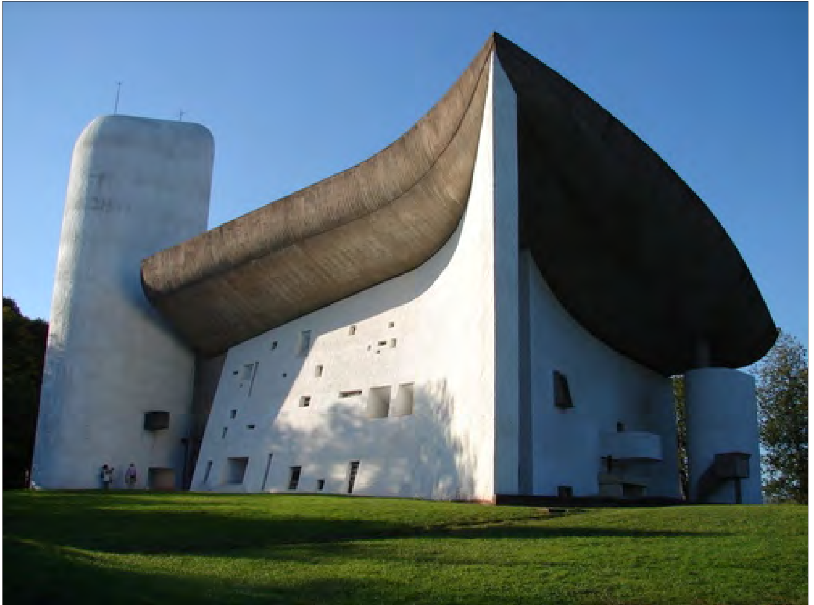
Ilustración 22. Fachadas sur y este de la Capilla de Nuestra Señora de Haut, Ronchamp (1951-53). Los vanos de diferentes tamaños que se abren en los muros, aparentemente están colocados al azar; en realidad, corresponden a las proporciones del Modulor. Confróntese la retícula que forman los vanos de la fachada sur (en la imagen es la de la izquierda) con la retícula inferior derecha que se presenta en la ilustración 18.
