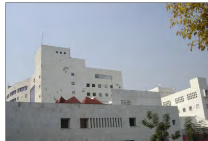
Fotografía 12. El Instituto Nacional de Rehabilitación, del arquitecto mexicano Sergio Mejía Ontiveros.
