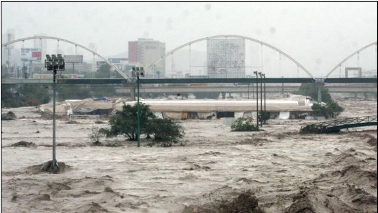
Ilustración 4.8 Puente "San Luisito" 2010 - Huracán Alex
