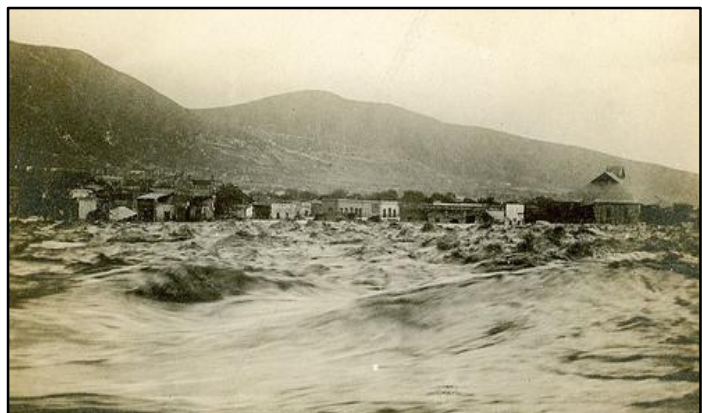
Ilustración 4.6 Monterrey 1909 en el poblado de "San Luisito"
