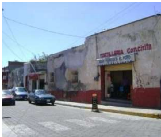
Img. 2.3.1 Vivienda 1 de concreto 31
