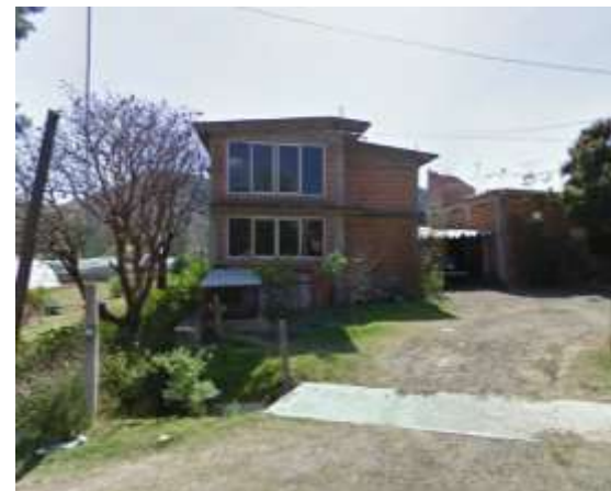
Img. 2.3.3 Vivienda 3 tabique rojo 31
