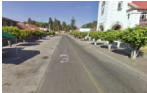
Img. 2.14 Limpieza y Bacheo en la zona 38
