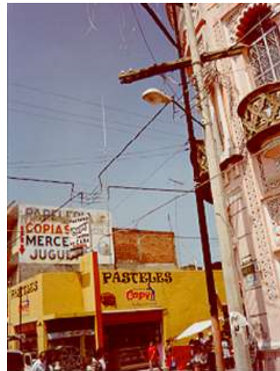
Img.2.12.2 Se observa en la Cd. de Atlixco una fuerte contaminación visual por cables de luz, teléfono, telégrafo e instalaciones de alumbrado. 35
