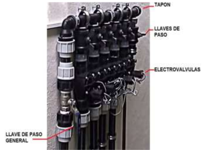
Fig. R.3 Cabezal de sistema de riego automatizado
