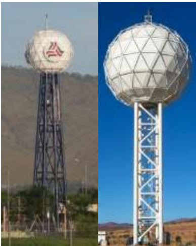
Fig. H.2 Tanque elevado Esférico
