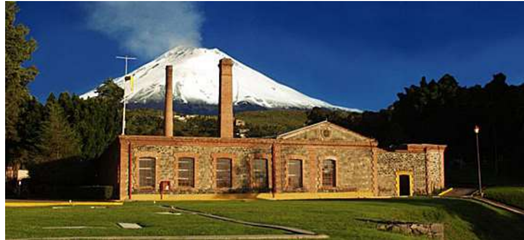
Img. 4.21 Centro Vacacional Metepec. Vista desde el Helipuerto. 71
