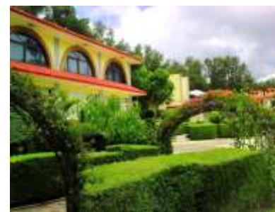
Img.4.32 Fachada Hotel "C" 75
