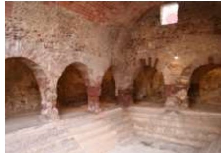
Img. 4.5 Celdas de Montbui 57
