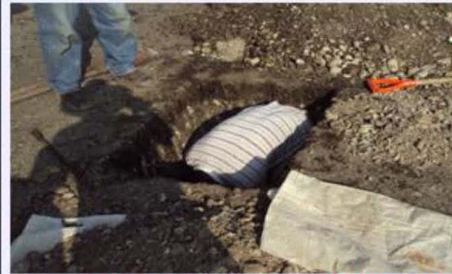
Se observa la realización de sondeos en la superficie de la carretera
