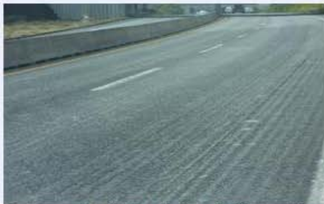
Se observa a detalle el levantamiento de deterioros tales como la pérdida de agregado grueso y roderas
