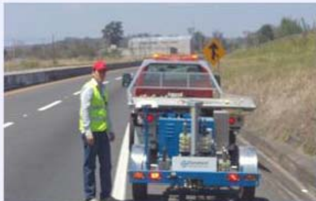
Se observa la preparación del equipo FWD
