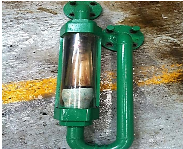
Figura 30. desmontaje del rotámetro.
