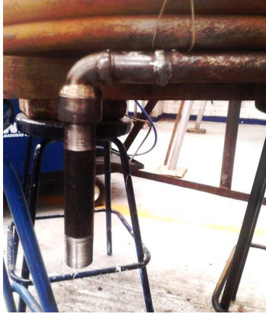
Figura 20. Extremo del serpentín ya reparado.
