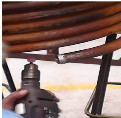
Figura 17. Preparación de la superficie a soldar.
