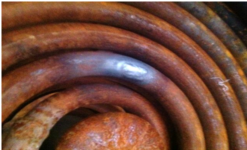
Figura 19. Reparación de la parte interna del hogar.
