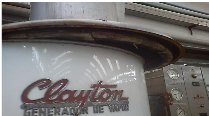
Figura 9. Desmontaje de la chimenea.
