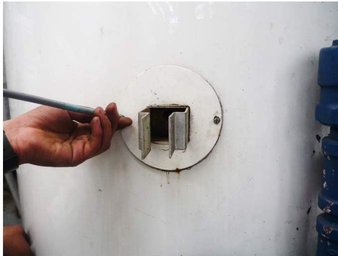
Figura 11. Soporte del sensor de expansión termostática y varilla del sensor.
