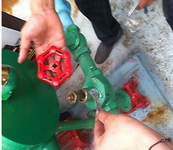
Figura 24. Servicio a las válvulas.
