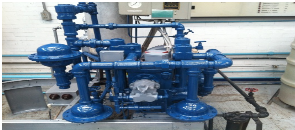
Figura 27. Aplicación de pintura a los sistemas de bombeo.
