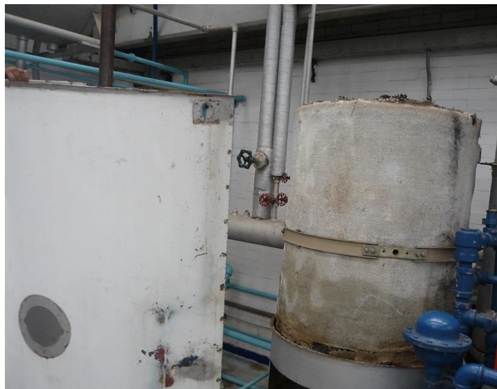
Figura 10. Generador de vapor sin carcasa.
