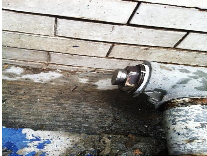
Figura 35. Instalación de la pieza ya terminada.
