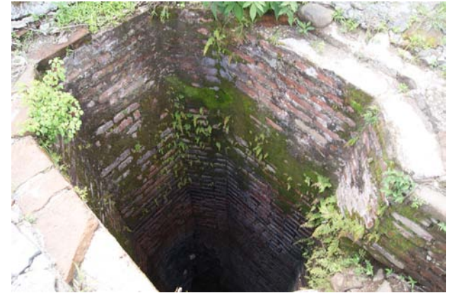
Fotografía 12 Cubos de agua del molino de Chicomocelo, estado actual. Septiembre 2012.
