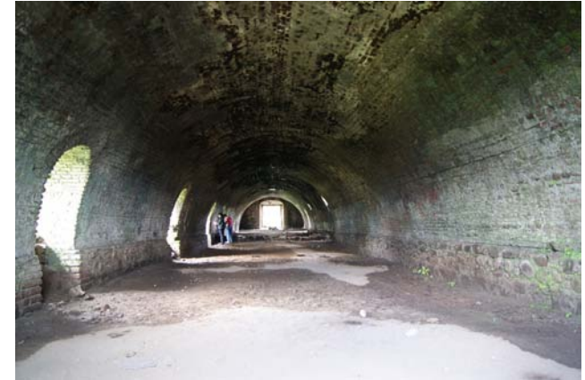
Fotografía 10 Bóveda de cañón corrido en casa de purga, estado actual. Agosto 2012.
