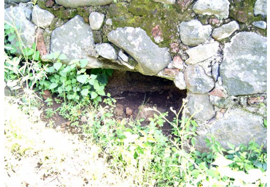
Fotografía 21 Paso por muro de calderas para alimentar canal, agosto 2012.
