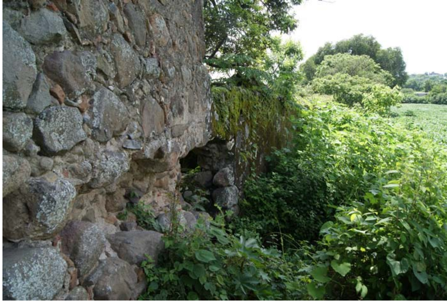
Fotografía 20 Cambio de dirección del canal general, hacia el jagüey, septiembre 2012.
