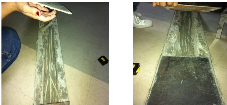
Figura 2.11 Canalizaciones en la sala de rayos X No.1.
