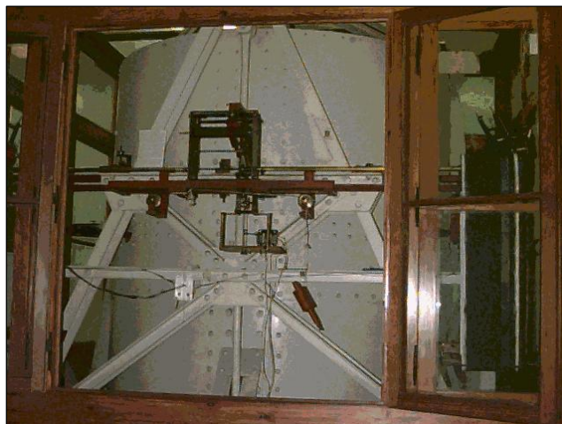
Figura 3.1 Sismógrafo horizontal Wiechert de 17,000 kilos 1910 (ref. 53)
