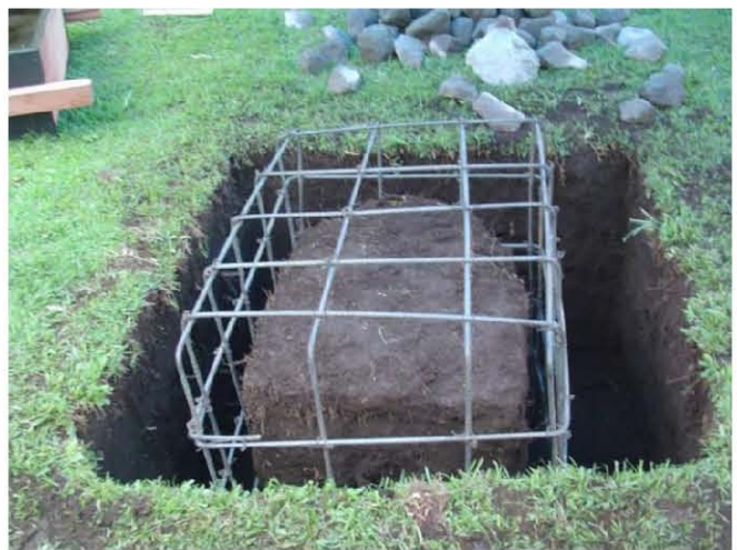
Figura 2.8-B Estación de campo libre instalación sobre suelo natural (ref. 46)
