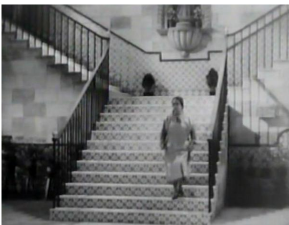
Imagen 2. Escaleras de vecindad La casa del Ogro
