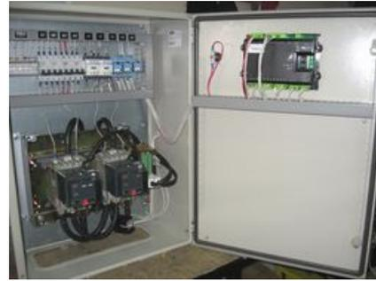
El TTA incluye un pulsador que permite realizar un encendido del motor sin realizar ninguna operación de transferencia de cargas eléctricas. Es útil para hacer un test manual periódico de estado del motor, para detectar anomalías en el mismo y así saber que se dispone del normal funcionamiento del mismo, cuando sea solicitado por una transferencia automática.
