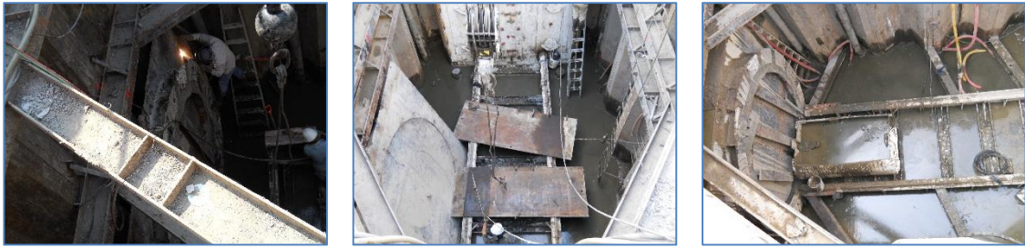
Hincado y operación de bombeo eyector.
