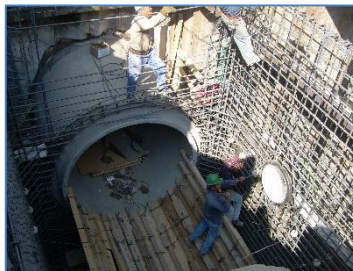
Muro de reacción y portal de entrada.
