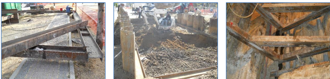
Armado y colocación de marcos de vigas madrina.
