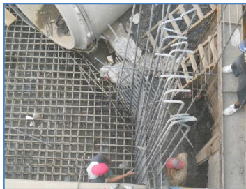
Construcción de cajas de disparo.
