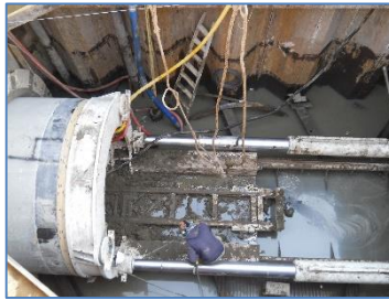
Construcción de cajas de disparo.
