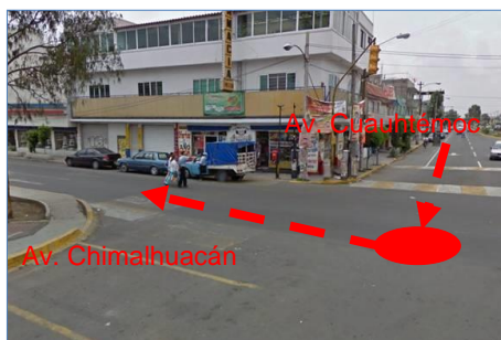
Foto 11.5.2.2 Trazo del Colector Cuauhtémoc intersección con el Colector Chimalhuacán, dicha intersección es en el pozo caja que se construyó en este cruce.
