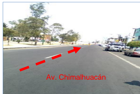
Foto 11.5.2.4 Trazo del colector por la Av. Chimalhuacán, casi esquina con la calle 10.
