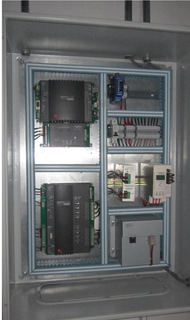
Fig. 4.4.1. Tablero de control de temperatura de un cuarto de IDF
