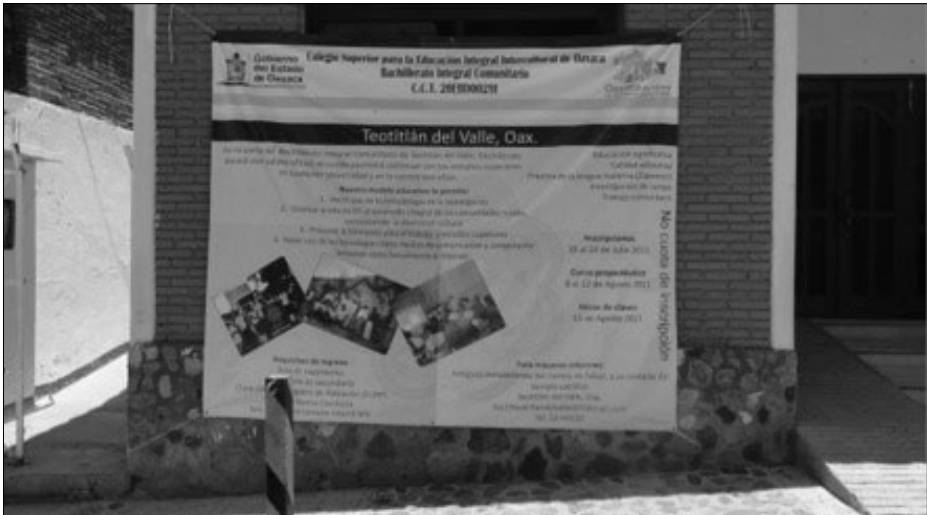
Imagen 2.4. Fachada de las instalaciones provisionales del BIC 29
