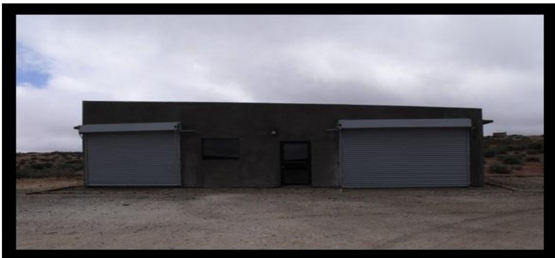
Imagen 8.-Almacén de refracciones y residuos.
