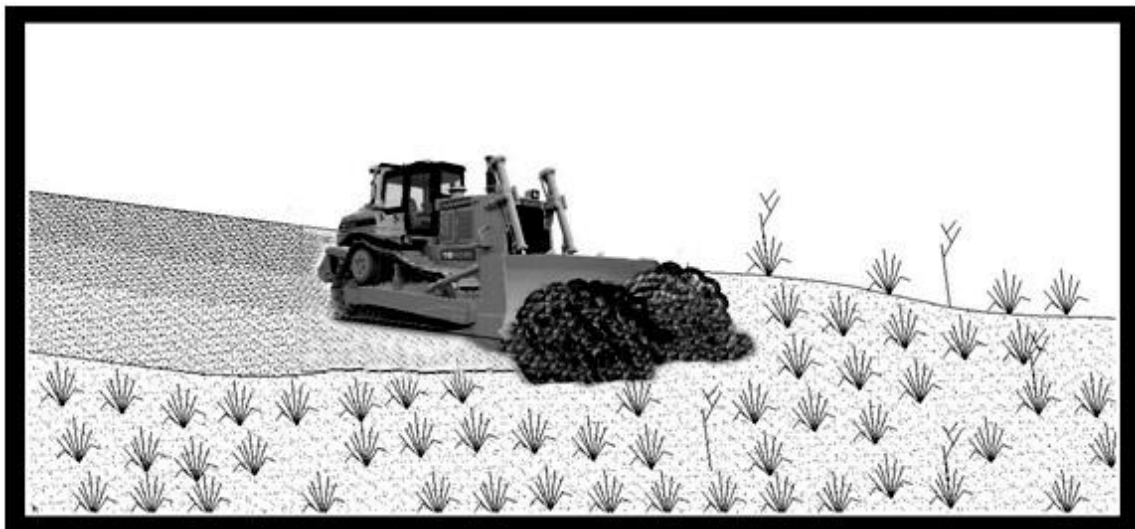
Fig. 25.-Desmonte realizado por un tractor buldócer.
