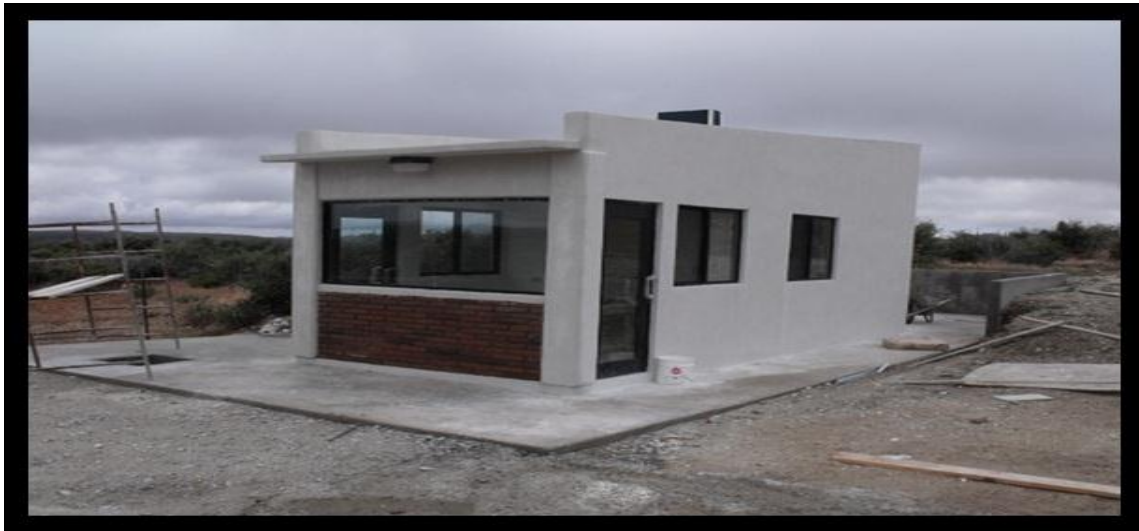
Imagen 7.-Caseta de vigilancia.
