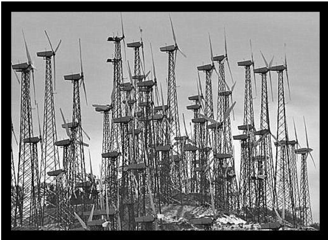
Fig. 48.-Contaminación del paisaje ocasionado por el gran número de aerogeneradores.
