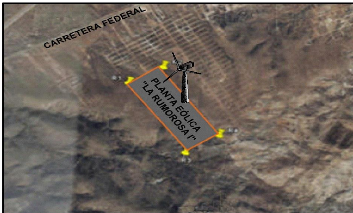
Imagen 4.-Localización de la central eólica “La Rumorosa I”.
